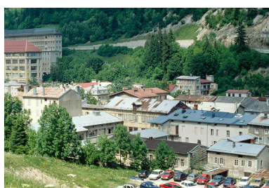
Vue d'ensemble depuis l'ouest. Phot. Laurent Poupard IVR43_19913901412ZA
