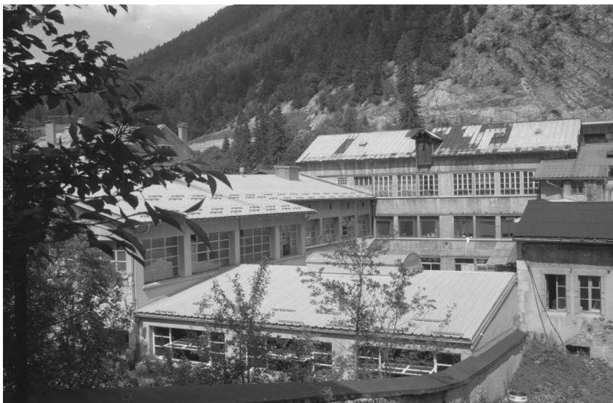
Façade postérieure des ateliers au n° 194.
