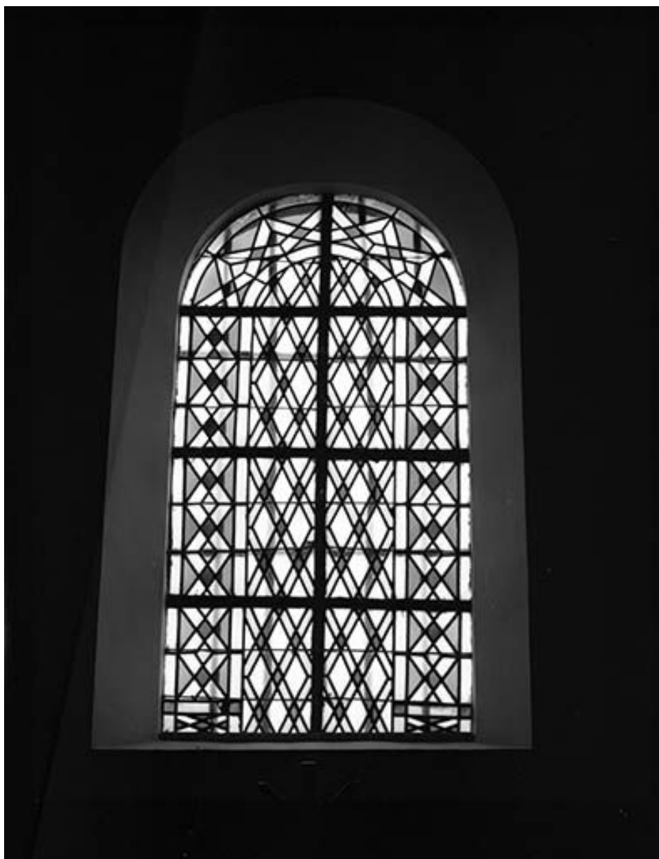
Baie 3 : vue d'ensemble.
