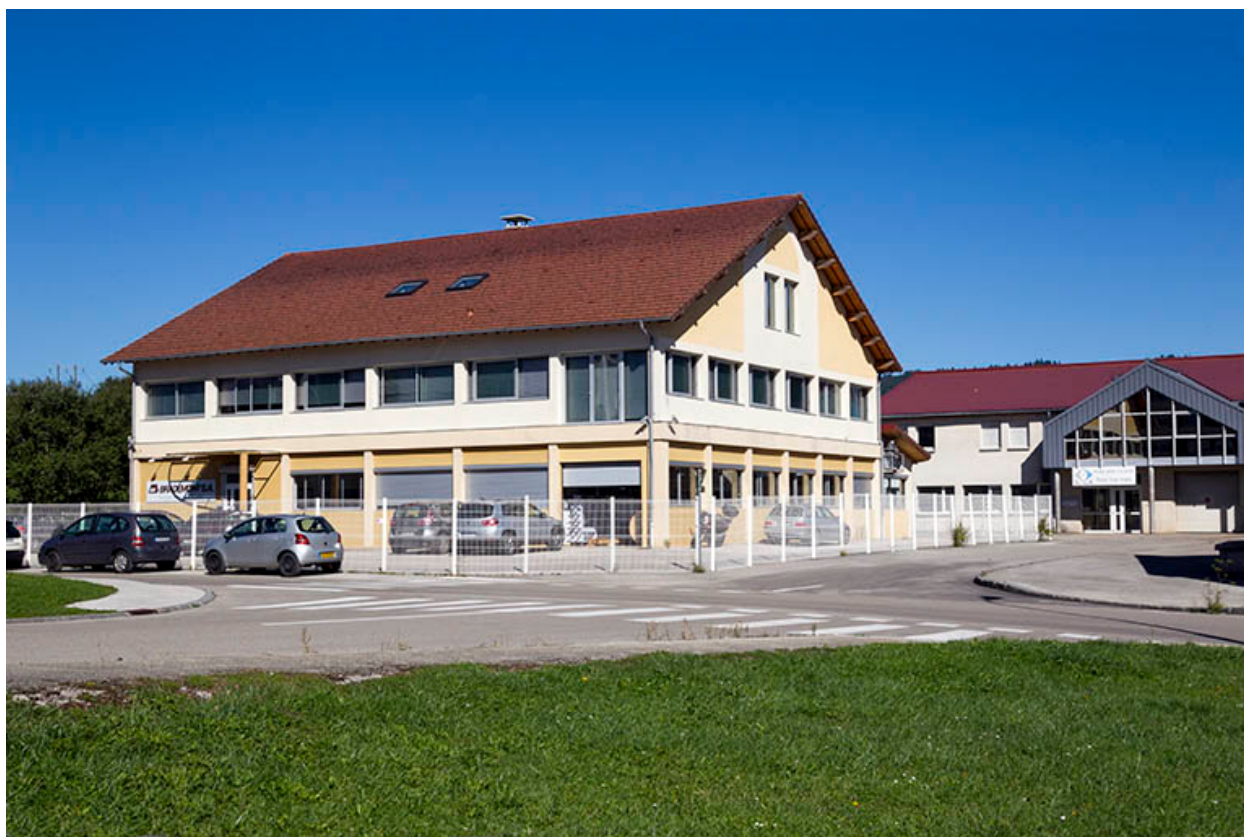
Façades antérieure et latérale droite.
