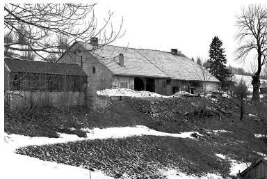
Vue de trois quarts. Phot. Dominique Dominguez IVR43_19802500100X
