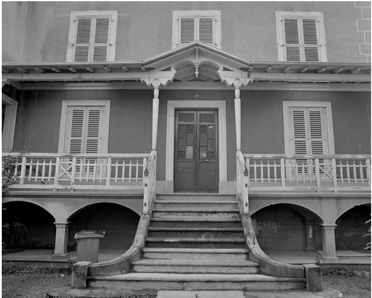
Façade antérieure, perron et galerie ouverte.
