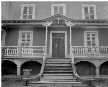
Façade antérieure, perron et galerie ouverte. Phot. Yves Sancey IVR43_19833900170X
