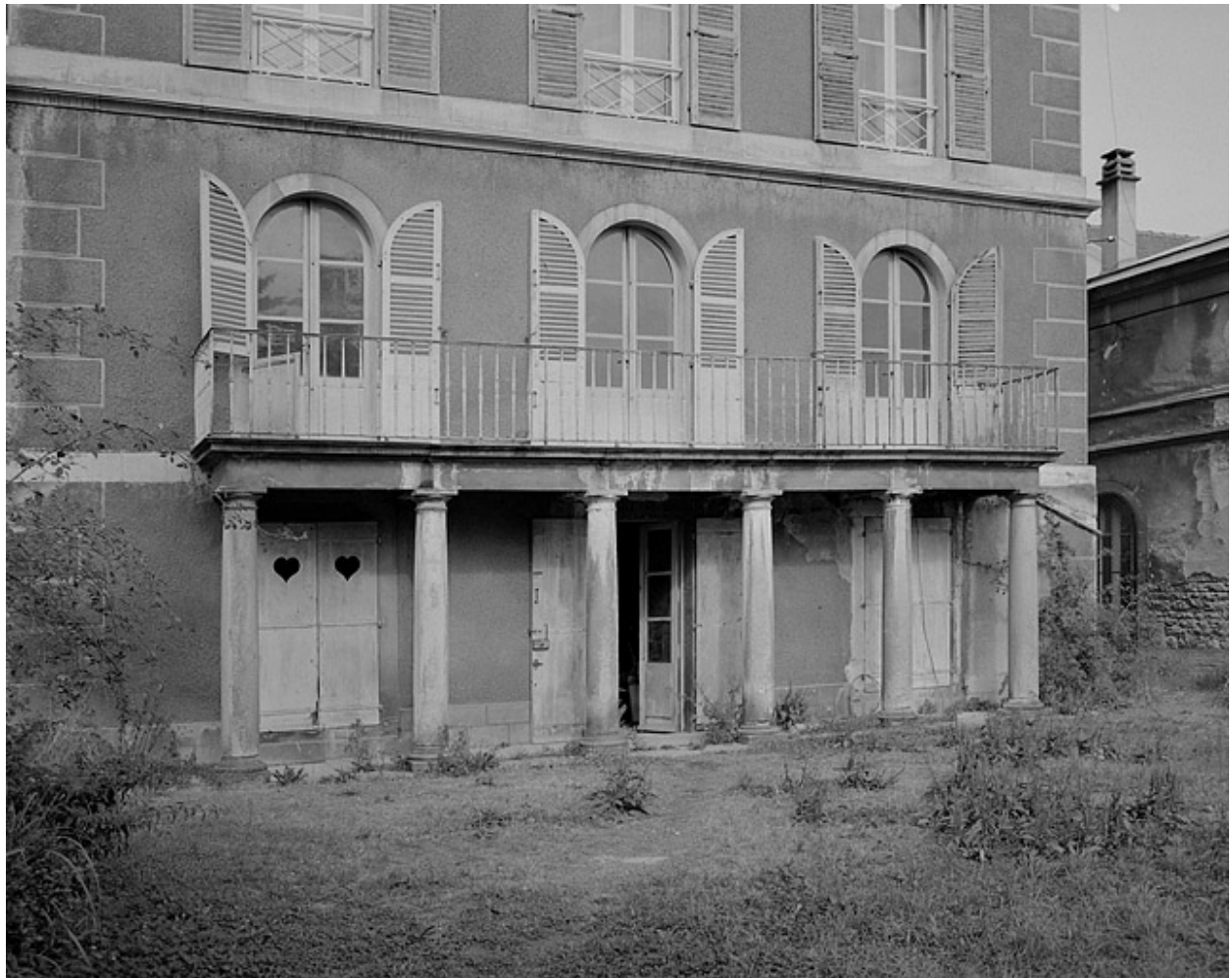
Façade postérieure, balcon sur colonnade.
