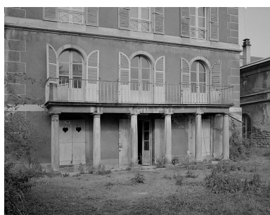
Façade postérieure, balcon sur colonnade. Phot. Yves Sancey IVR43_19833900171X
