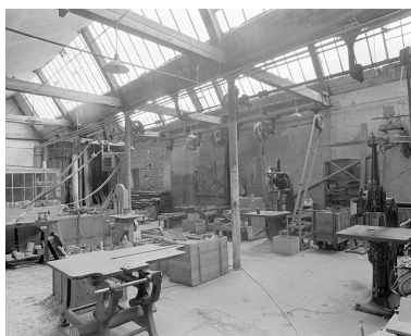
Vue d'ensemble de l'atelier depuis le sud-est. Phot. Yves Sancey IVR43_20022500729X
