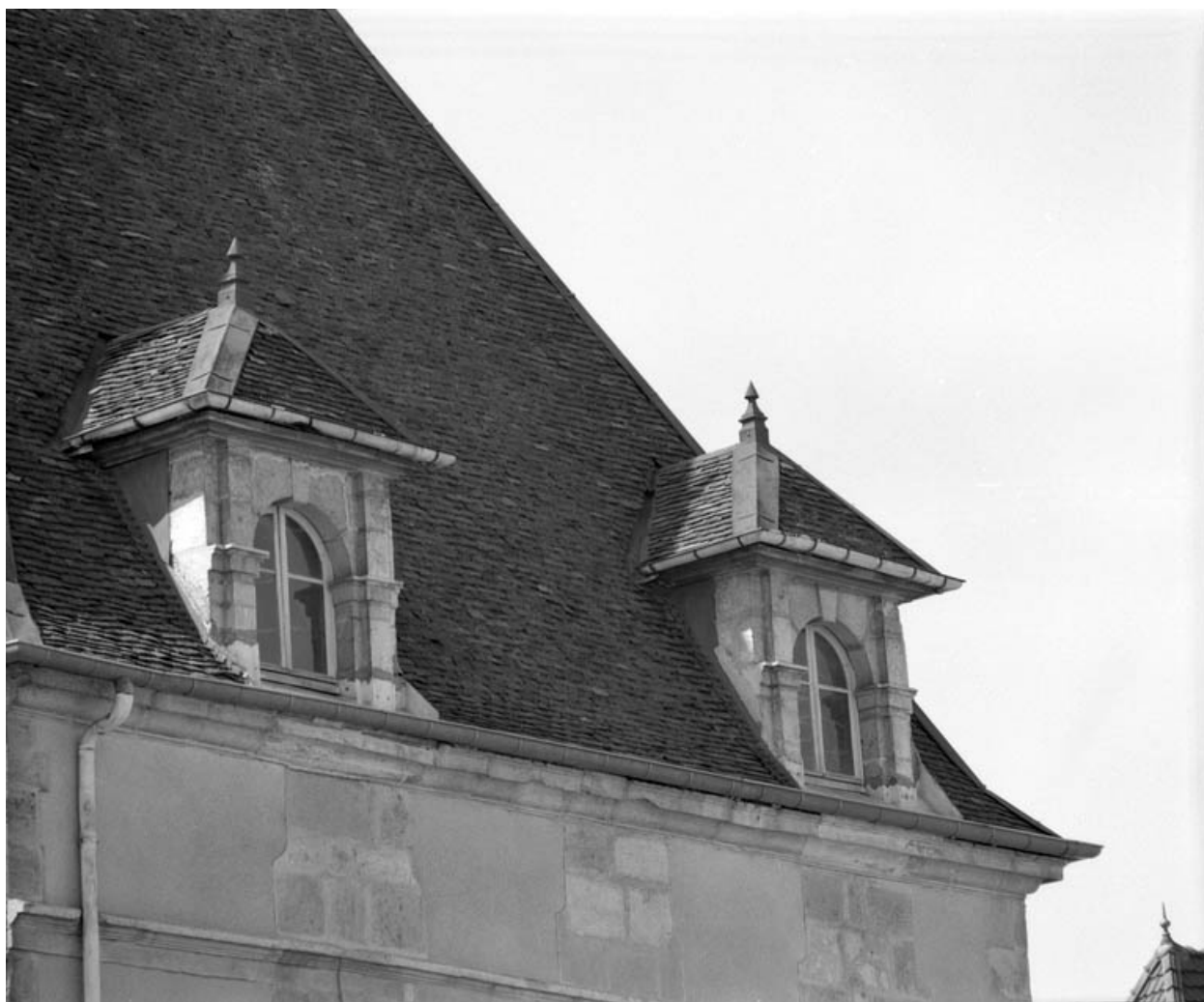
Détail des lucarnes.
