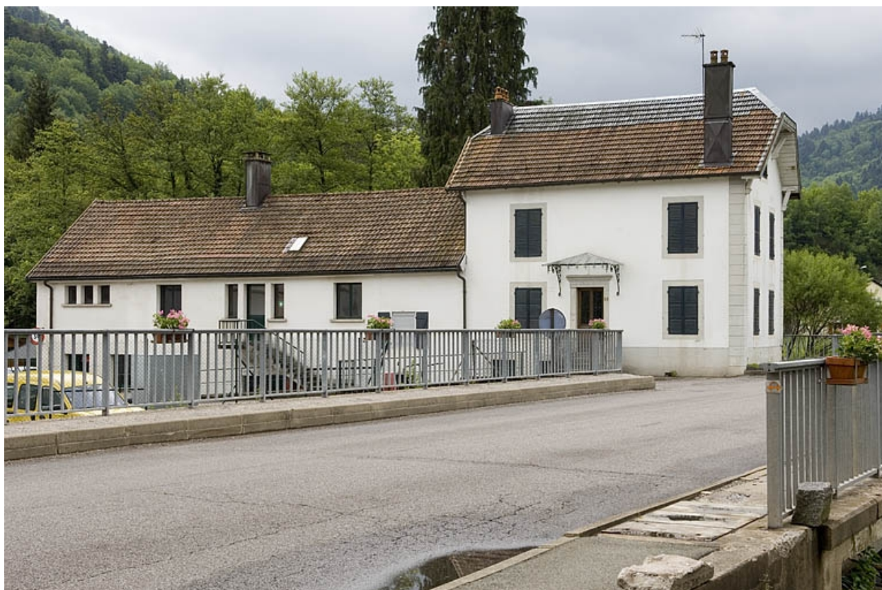
Le bâtiment de l'ancien moulin.
