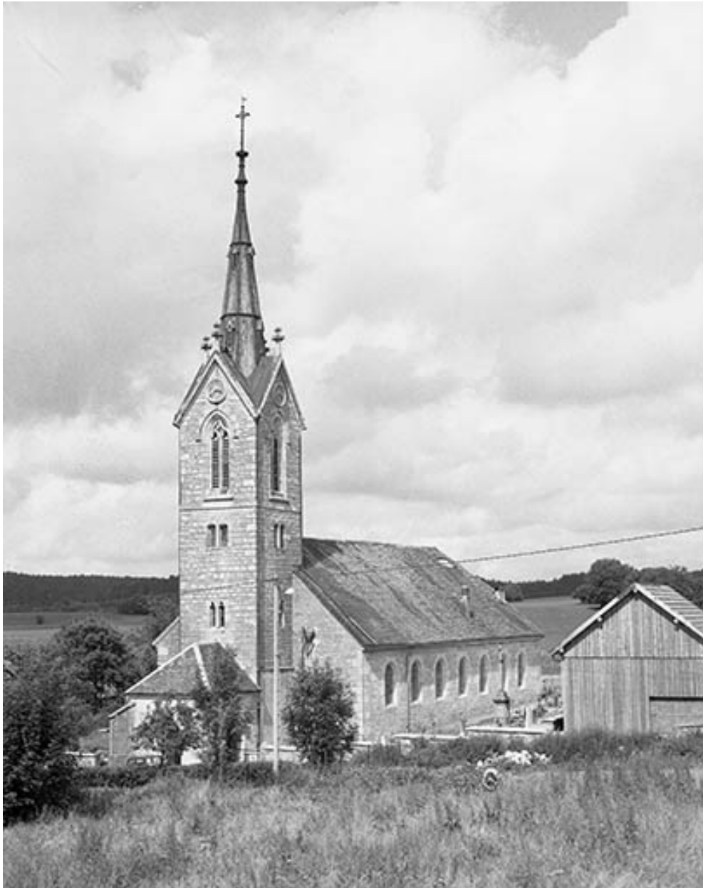
Extérieur : faces antérieure et latérale droite.
