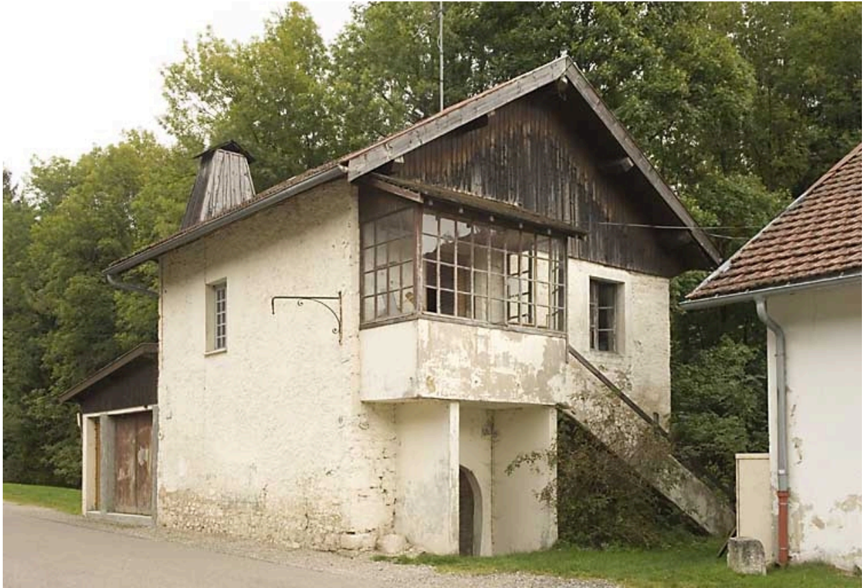
Partie nord : maison.
