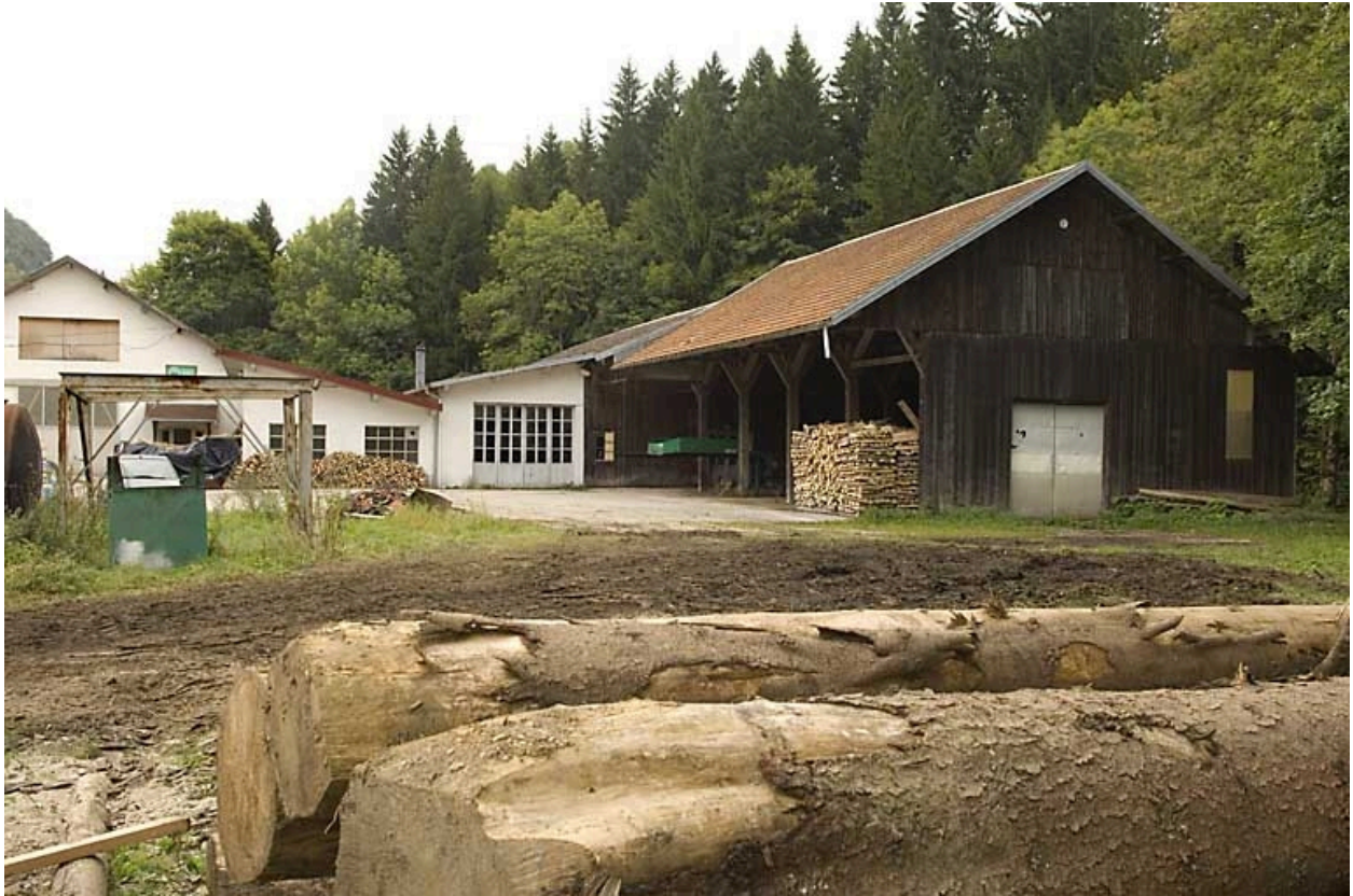
Partie nord : hangar.
