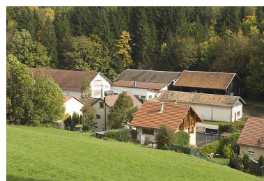
Vue générale rapprochée, depuis le sud-ouest. Phot. Jérôme Mongreville IVR43_20082501073NUC2A
