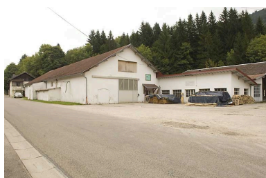
Partie nord du site : vue générale. Phot. Jérôme Mongreville IVR43_20082501068NUC2A
