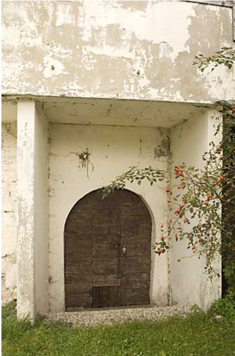
Partie nord : porte au rez-de-chaussée de la maison.
