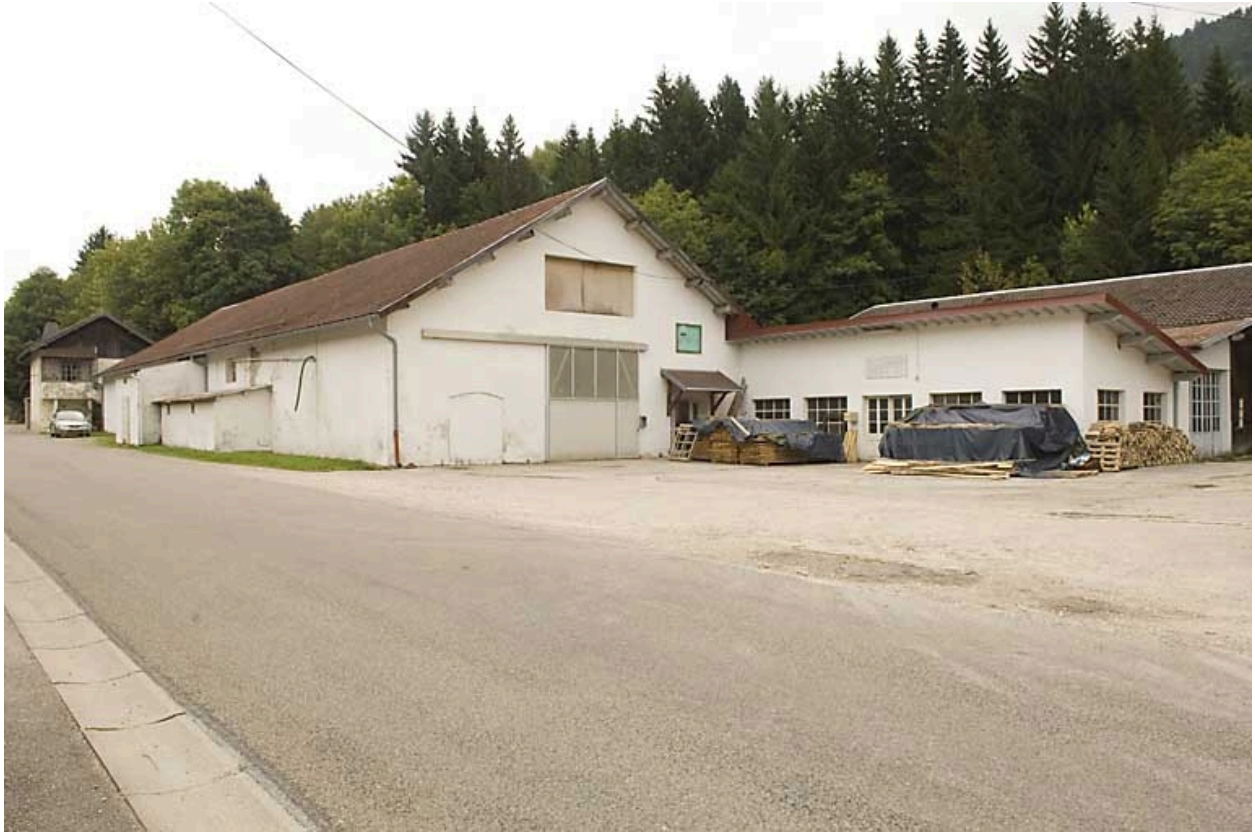
Partie nord du site : vue générale.
