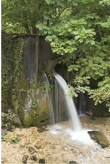
Ouvrage lié à l'eau. Phot. Jérôme Mongreville IVR43_20082501065NUC2A
