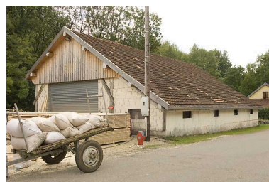
Partie sud : 2e bâtiment. Phot. Jérôme Mongreville IVR43_20082501072NUC2A
