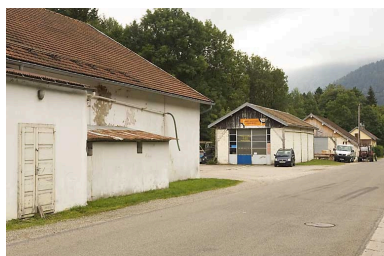
Partie sud du site : vue générale. Phot. Jérôme Mongreville IVR43_20082501066NUC2A
