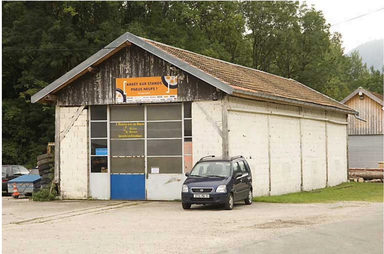
Partie sud : 1er bâtiment.
