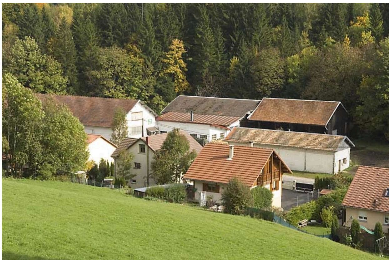
Vue générale rapprochée, depuis le sud-ouest.
