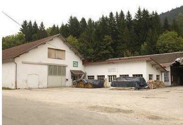
Partie nord : vue rapprochée. Phot. Jérôme Mongreville IVR43_20082501069NUC2A
