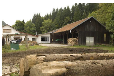
Partie nord : hangar. Phot. Jérôme Mongreville IVR43_20082501071NUC2A
