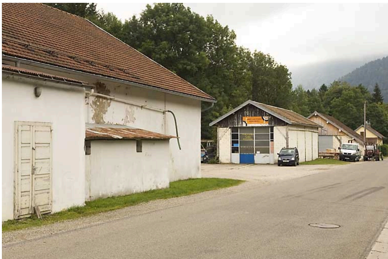
Partie sud du site : vue générale.
