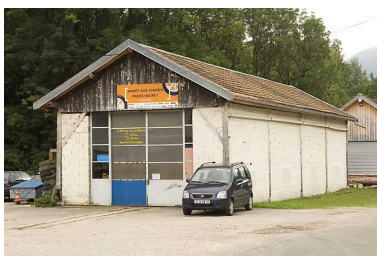
Partie sud : 1er bâtiment. Phot. Jérôme Mongreville IVR43_20082501067NUC2A
