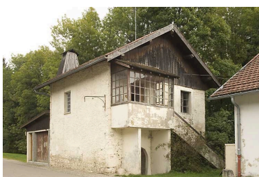
Partie nord : maison. Phot. Jérôme Mongreville IVR43_20082501063NUC2A
