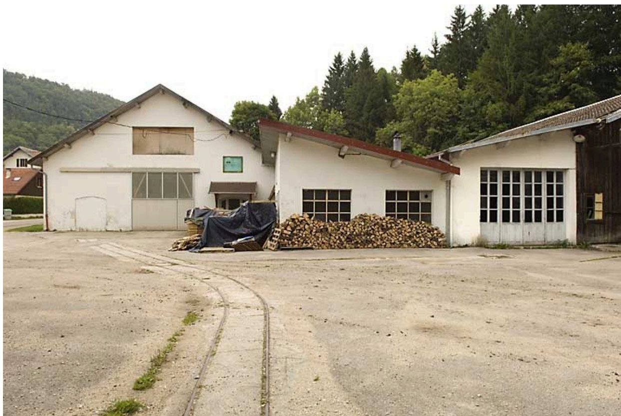
Partie nord : bâtiments vus de face.
