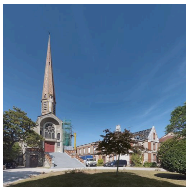
Eglise, chapelle et presbytère. Vue de trois quarts. Phot. Thierry Kuntz IVR26_20128900680NUC4A
