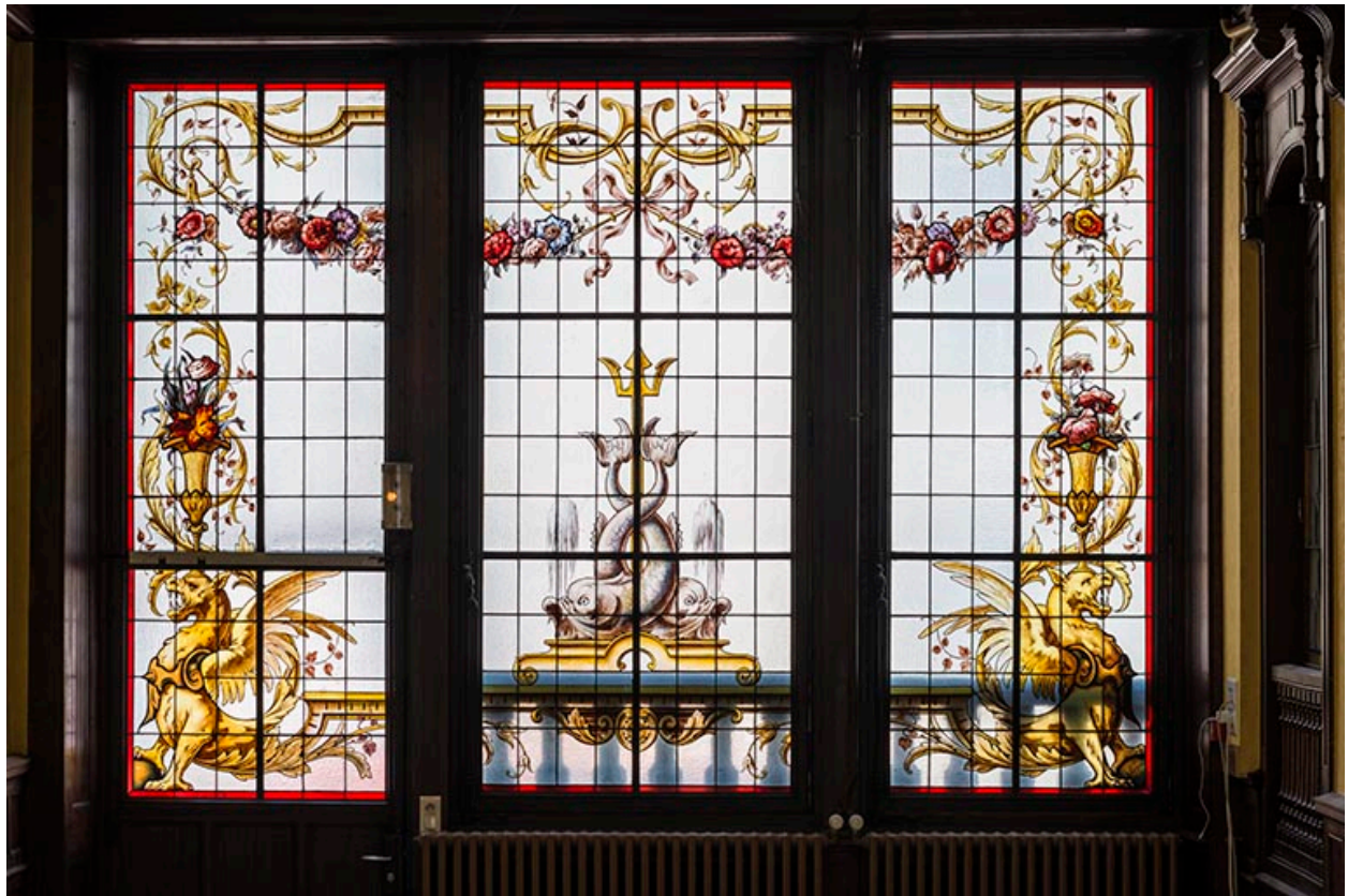
Vue générale de la verrière, côté rue.
