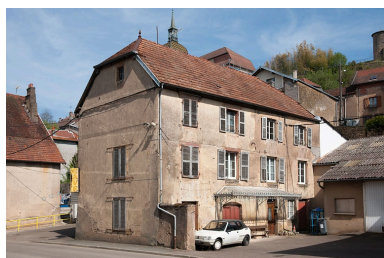
Vue générale du bâtiment (AL 543) situé à gauche de la cour. Phot. Jérôme Mongreville IVR43_20102500377NUC4A
