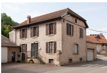
Vue générale du bâtiment (AL 549) situé à droite de la cour. Phot. Jérôme Mongreville IVR43_20102500693NUC4A
