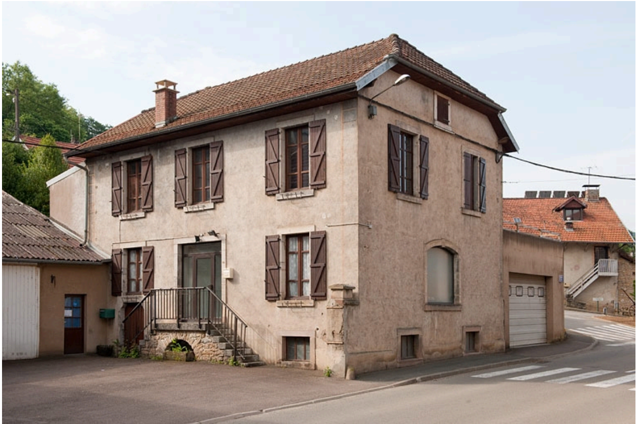
Vue générale du bâtiment (AL 549) situé à droite de la cour.
