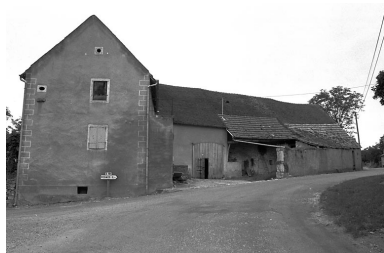
Ferme située route de Pesmes. Phot. Bernard Lardière IVR43_19817000475Z
