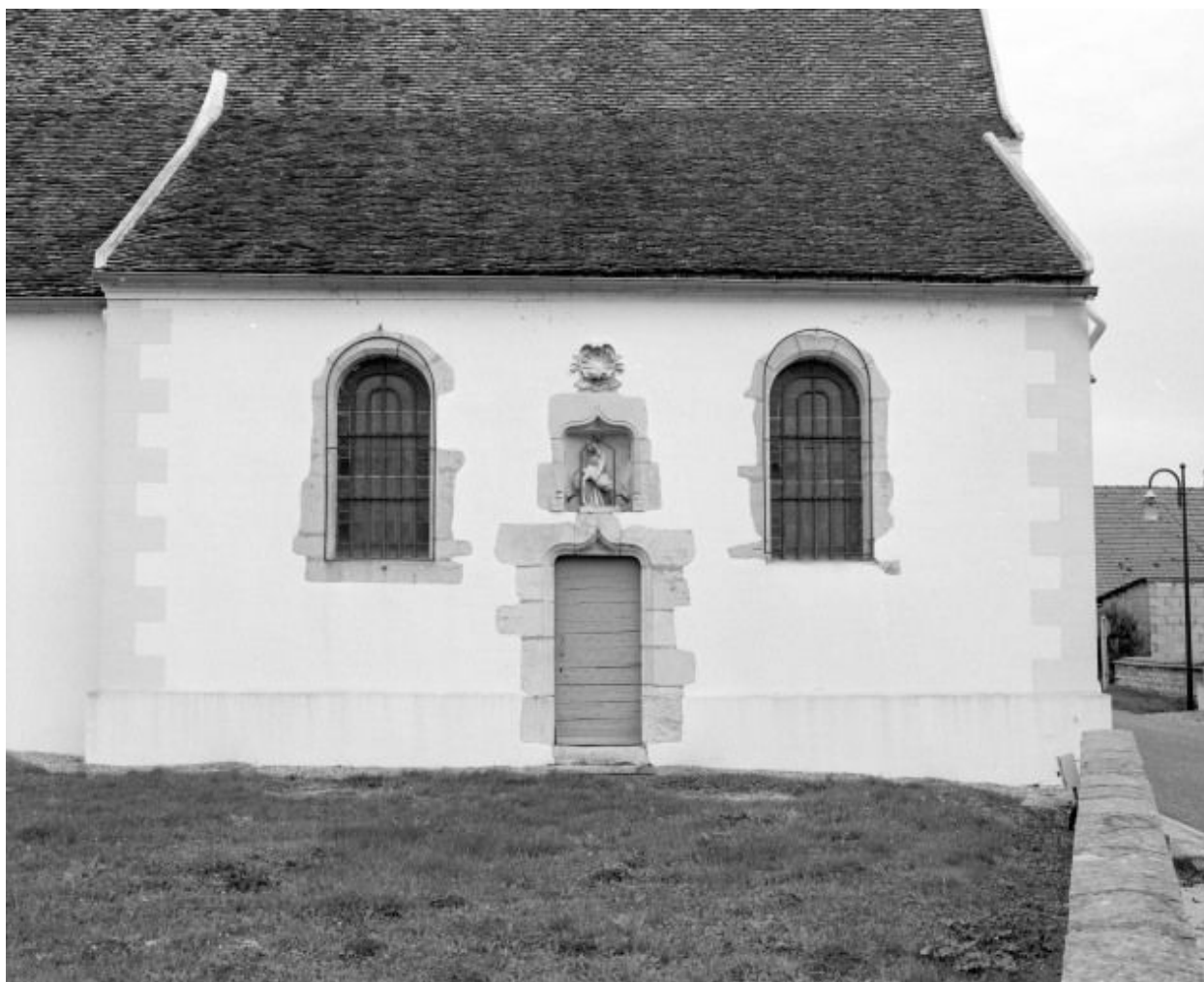
Elévation latérale de la chapelle gauche.
