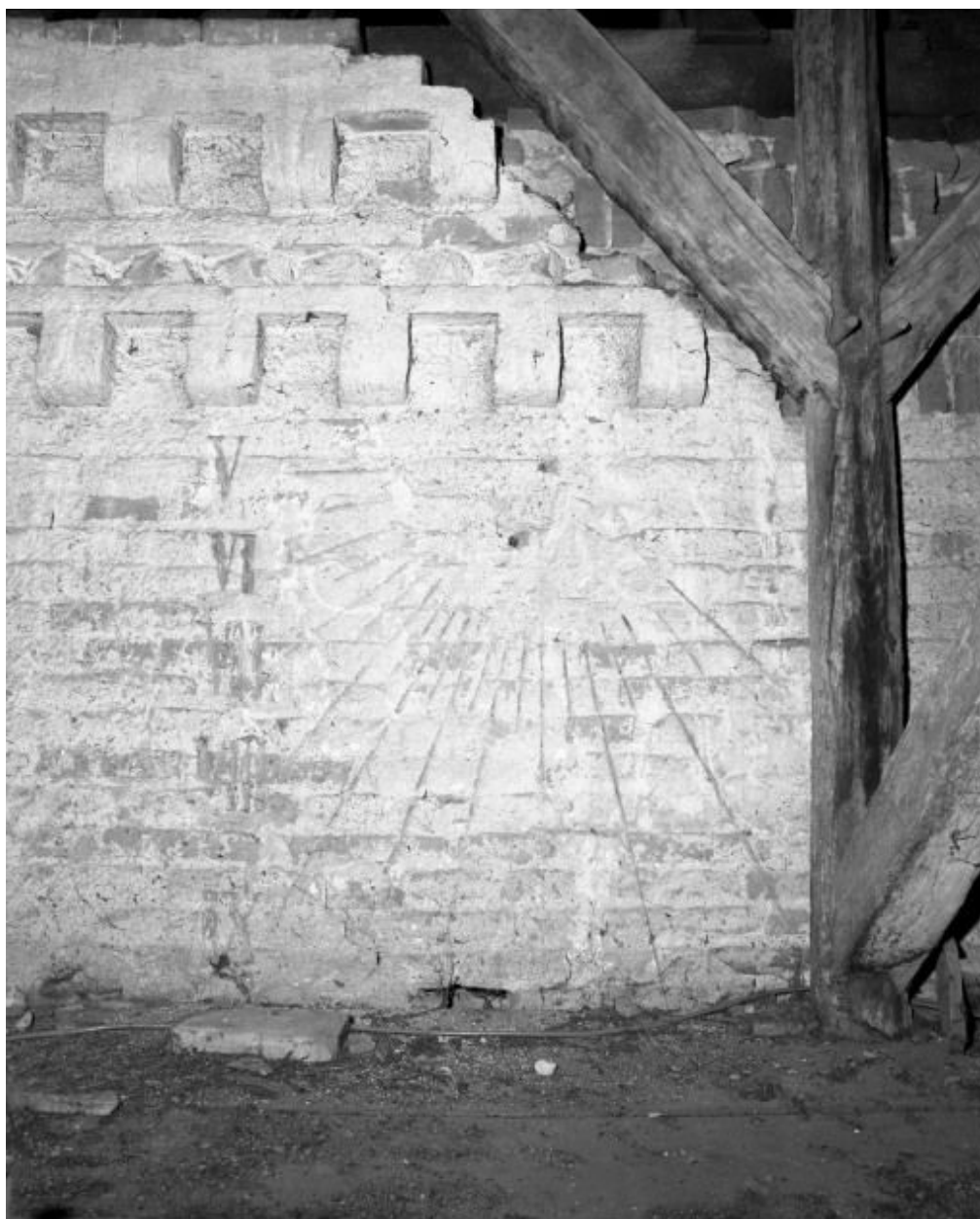
Comble de la chapelle droite : cadran solaire.
