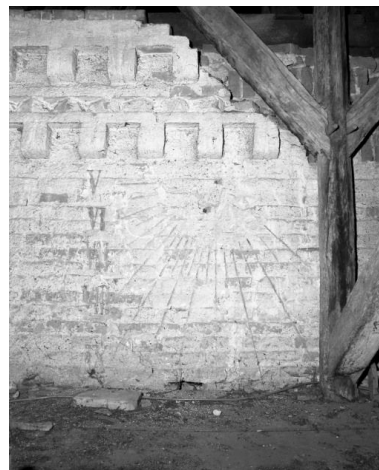
Comble de la chapelle droite : cadran solaire. Phot. Michel Rosso IVR26_20017101209X
