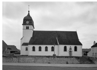
Elévation gauche. Phot. Michel Rosso IVR26_20017101215V
