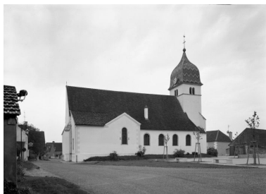
Elévation gauche. Phot. Michel Rosso IVR26_20017101213V
