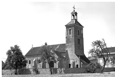
Façade latérale sud. Phot. Bernard Lardière IVR43_19767000761X
