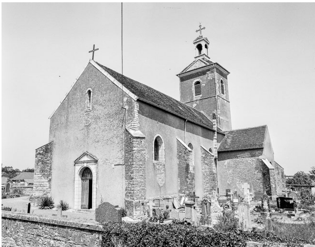
Façades antérieure et latérale droite.
