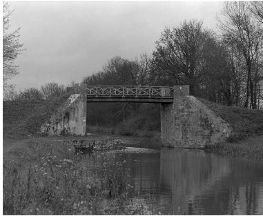
Vue d'ensemble prise de l'amont.
