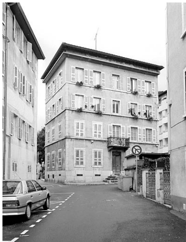
Elévation antérieure, de trois quarts gauche. Phot. Yves Sancey IVR43_20033900452X
