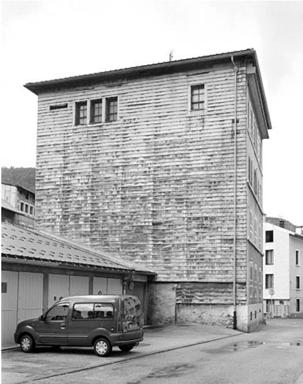
Elévation postérieure, de trois quarts droite.
