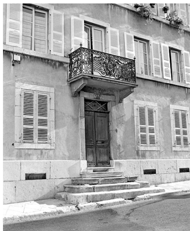
Entrée. Phot. Yves Sancey IVR43_20033900457X
