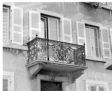
Balcon du premier étage. Phot. Yves Sancey IVR43_20033900458X
