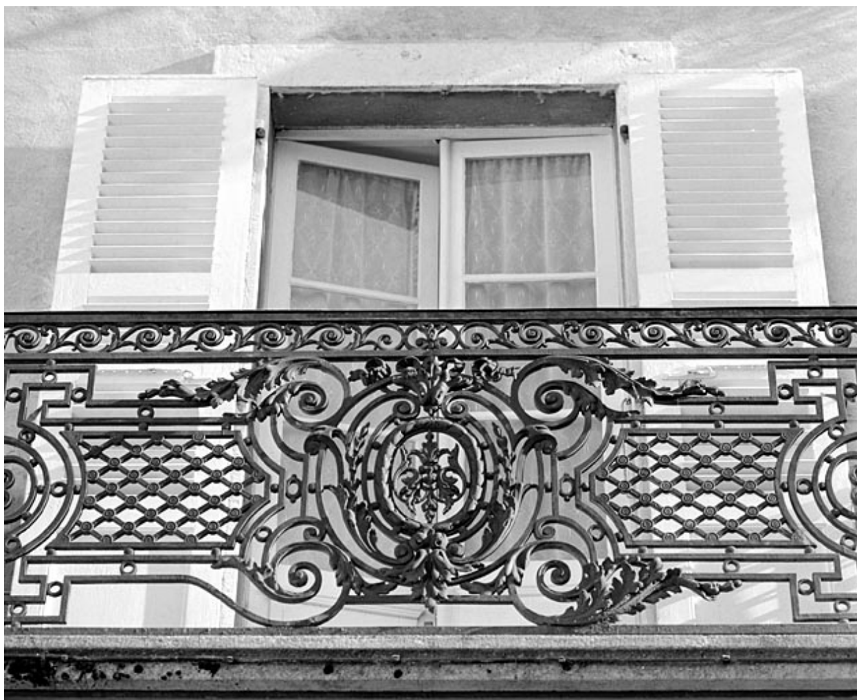
Balcon du premier étage : détail du garde-corps.
