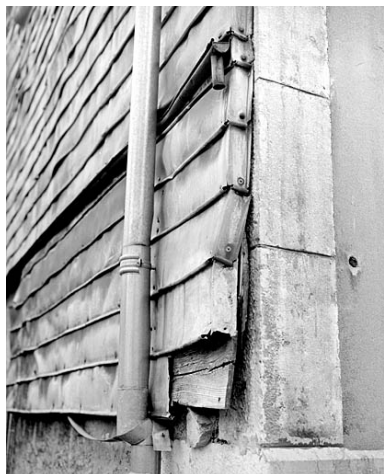
Essentage de tôle sur le mur sud. Phot. Yves Sancey IVR43_20033900455X
