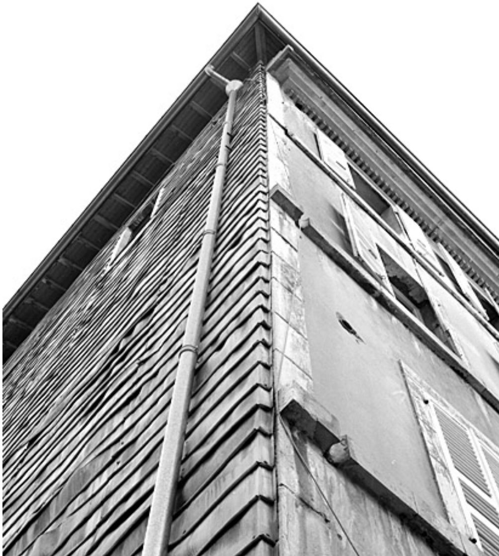
Angle des murs sud et est.
