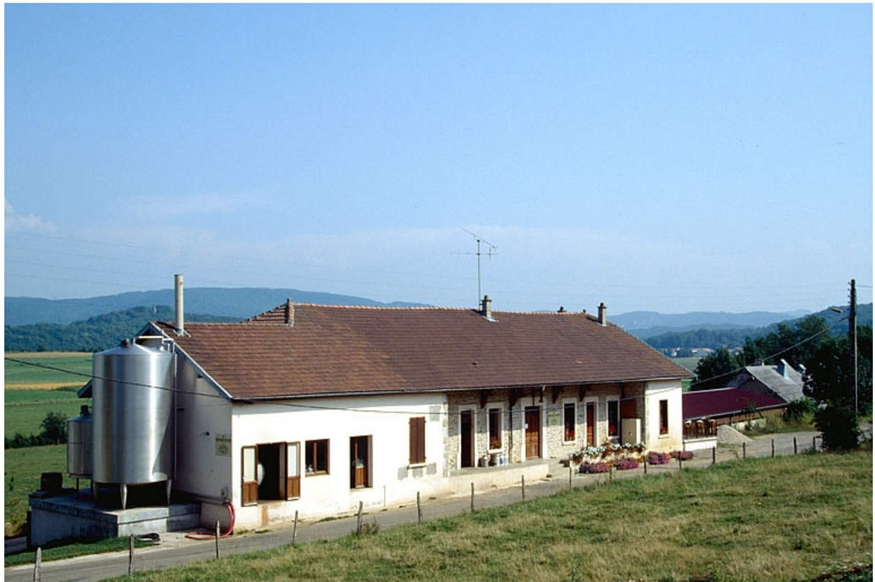
Façade antérieure de la fromagerie.
