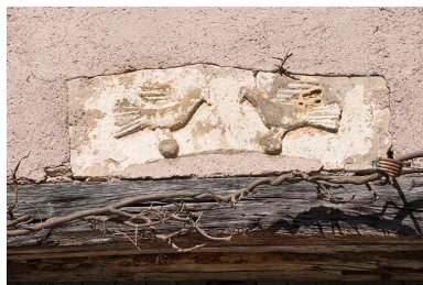
Détail d'un des linteaux. Phot. Jérôme Mongreville IVR43_20177000197NUC4A
