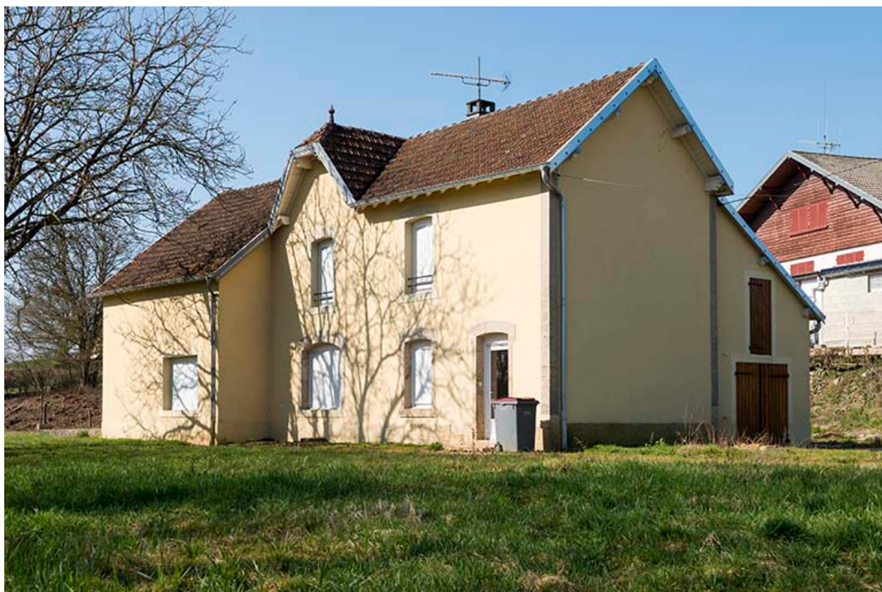
Ancienne halte ferroviaire.
