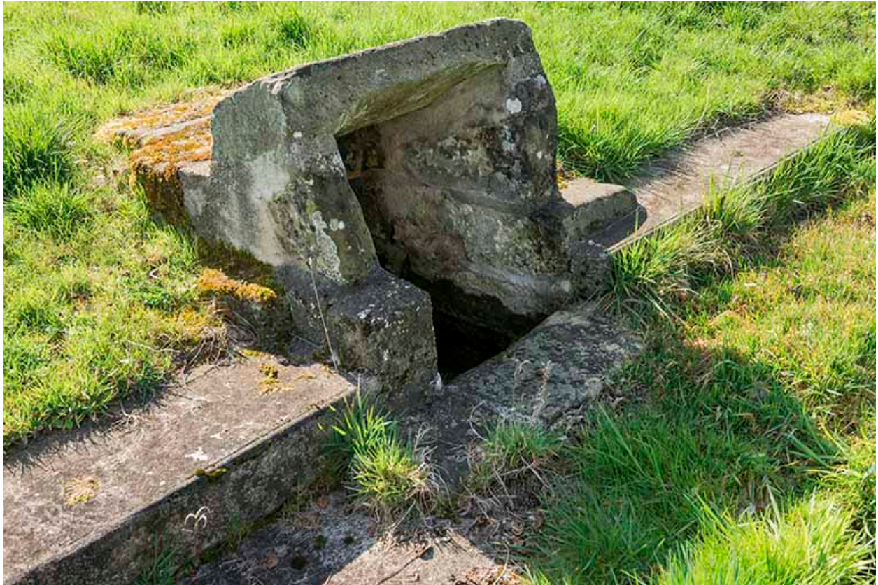
Fontaine d'alimentation du bassin.
