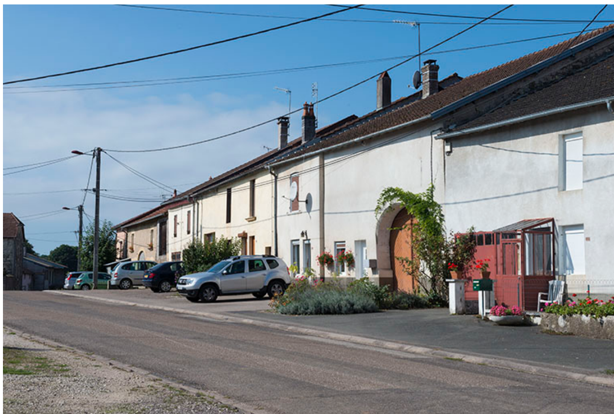
Vue générale, Grande rue.
