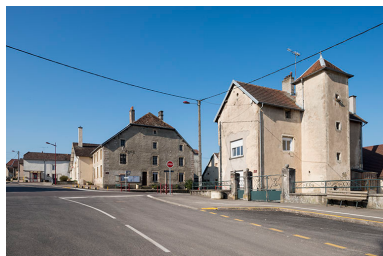
L'école et la mairie. Phot. Jérôme Mongreville IVR43_20177000173NUC4A
