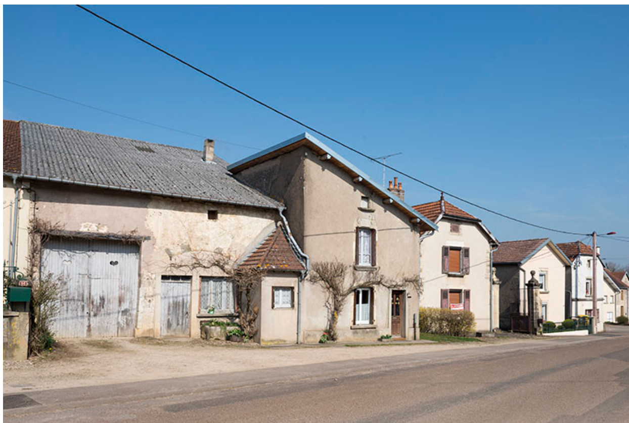
Vue générale, Grande rue.
