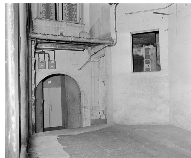
Porte d'escalier. Phot. Yves Sancey IVR43_19853900309X
