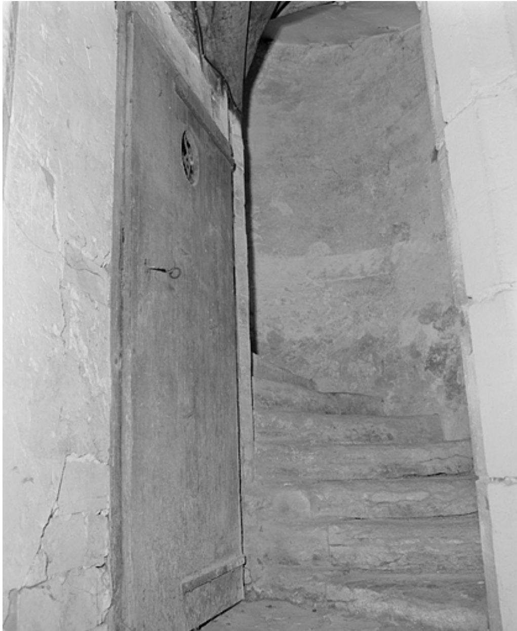
Détail de l'escalier.
