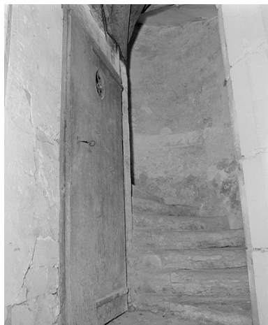
Détail de l'escalier. Phot. Yves Sancey IVR43_19853900310X
