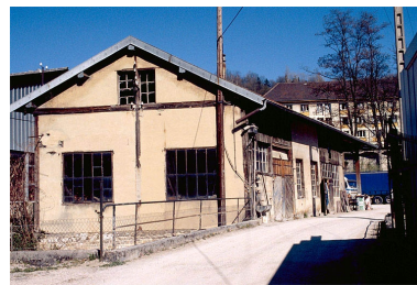
Atelier de réparation depuis la rive gauche.
