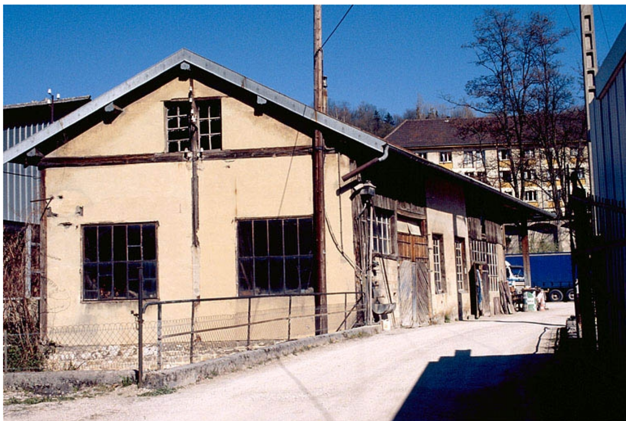
Atelier de réparation depuis la rive gauche.
