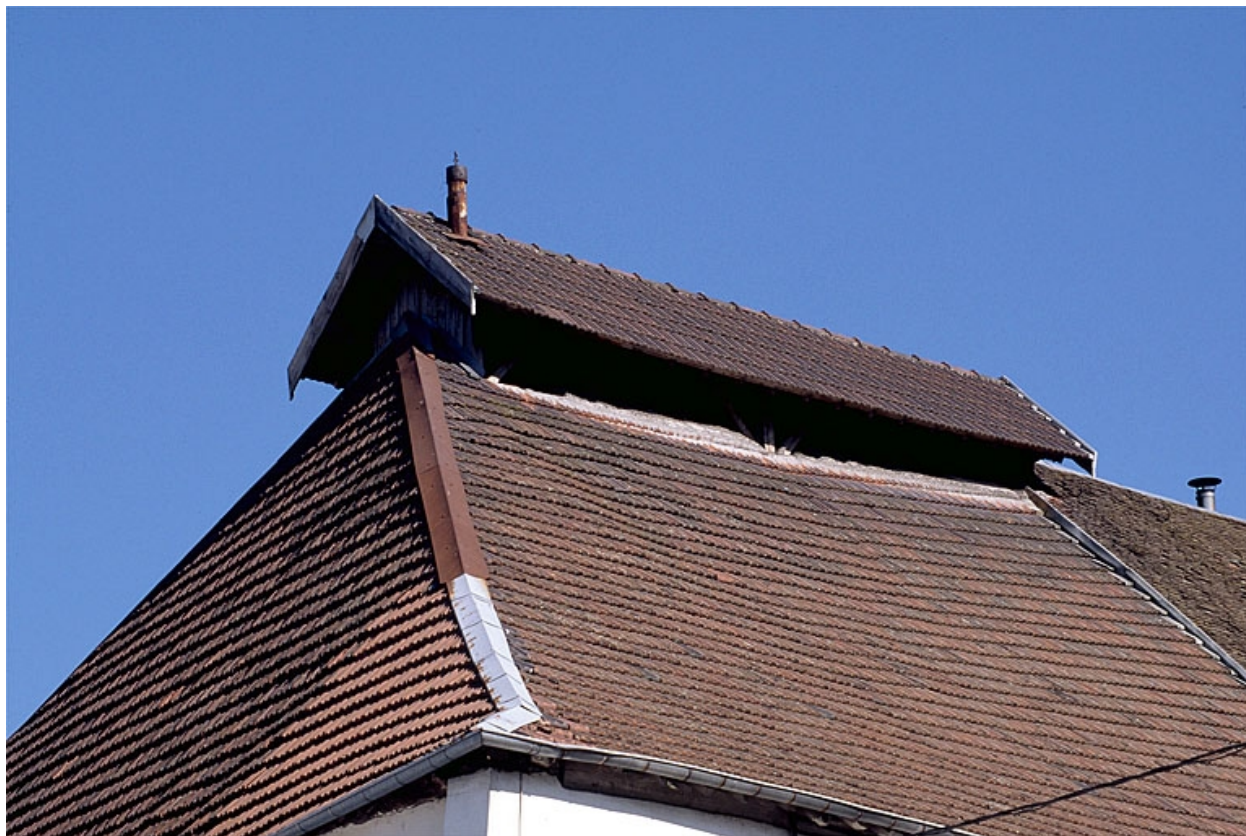
Atelier de fabrication : détail de la toiture.
