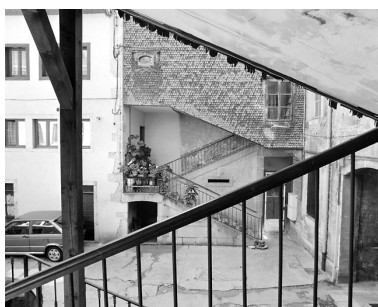
Escalier de l'hôtel au n° 149 rue de la République. Noter l'essentage de tavaillons (bardeaux). Phot. Yves Sancey IVR43_20033900739X
