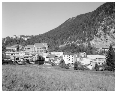
Les quartiers de l'école du Haut et du lycée Victor Bérard. A droite, élévation postérieure des bâtiments de la Société des Lunetiers. Phot. Yves Sancey IVR43_20033900365X
