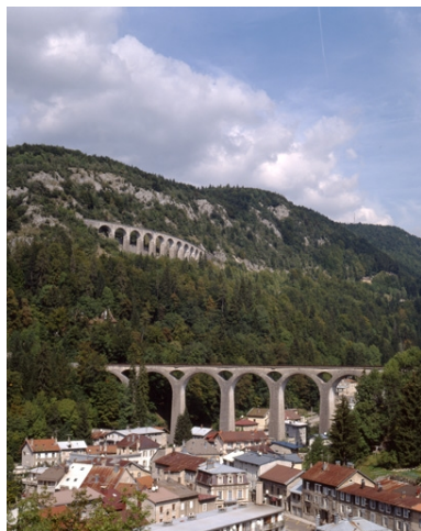
Le grand viaduc, avec celui des Crotes en arrière-plan. Phot. Jérôme Mongreville IVR43_20003900488XA
