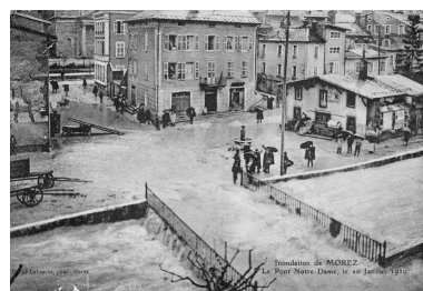
Inondation de Morez. Le Pont Notre-Dame, le 20 Janvier 1910. Phot. Yves Sancey, Autr. NEPASUTILISERLaheurte (photographe) IVR43_20103900711NUC2A
