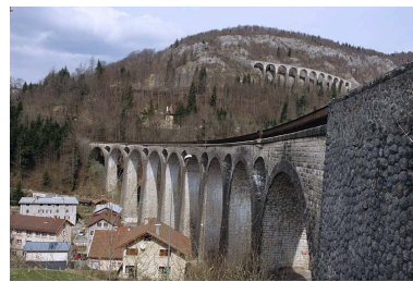
Le grand viaduc vu en enfilade, depuis l'extrémité côté gare. Phot. Yves Sancey IVR43_20053900500ZA
