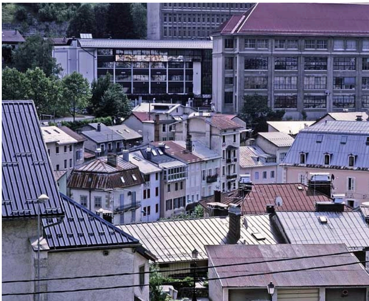
Toiture des bâtiments du quai Aimé Lamy.
