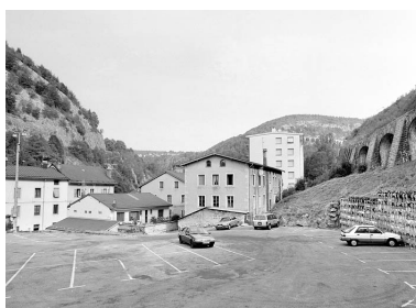
Emplacement de l'ancienne piscine, entre la rue de la Concorde (à gauche) et le mur de soutènement de l'avenue Charles de Gaulle. Au centre, l'ancienne usine de la coopérative Les Lunetiers réunis. Phot. Yves Sancey IVR43_20033900183X
