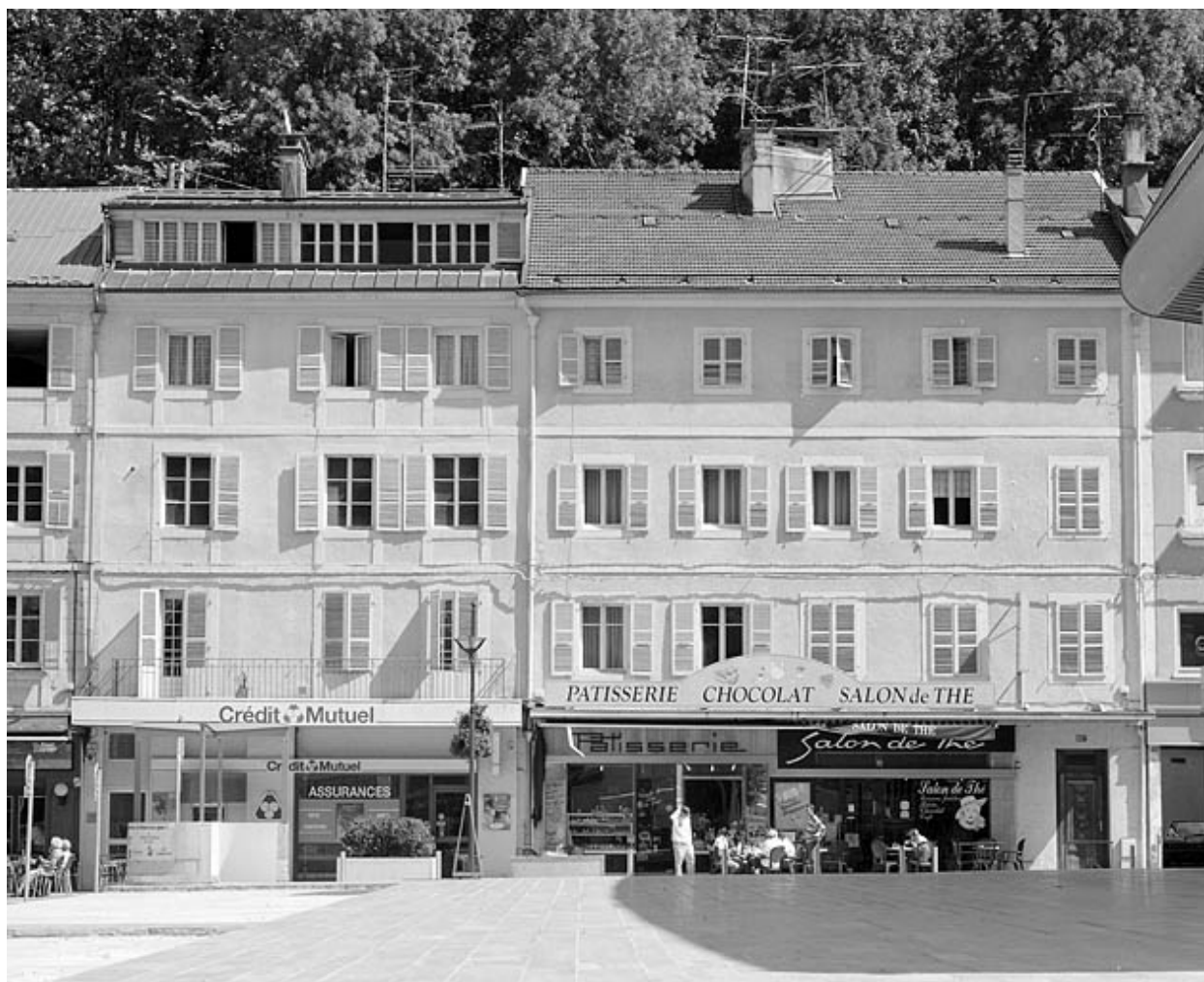
Façade antérieure des immeubles aux n° 135 et 137 rue de la République.
