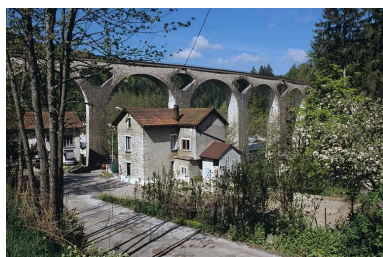
Le grand viaduc et une maison, vus du vallon de l'Evalude en amont. Phot. Yves Sancey IVR43_20053900513ZA
