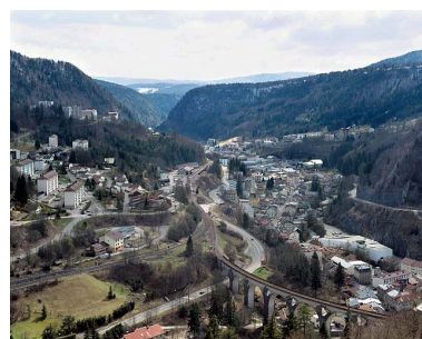
Vue d'ensemble depuis le viaduc des Crottes. Phot. Yves Sancey IVR43_20053900398XA
