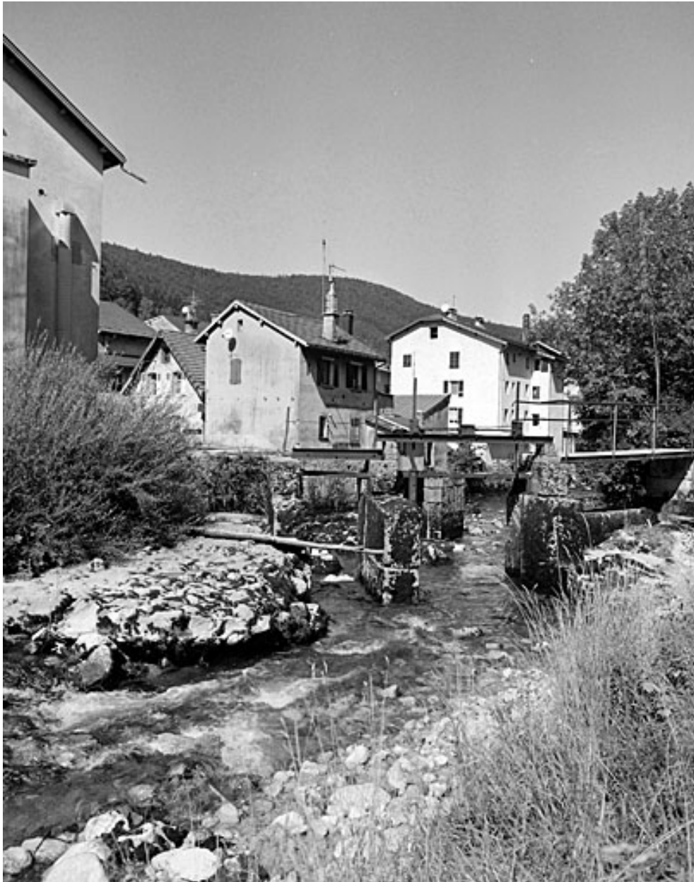
La Bienne en amont du barrage de l'ancienne usine Cochet.
