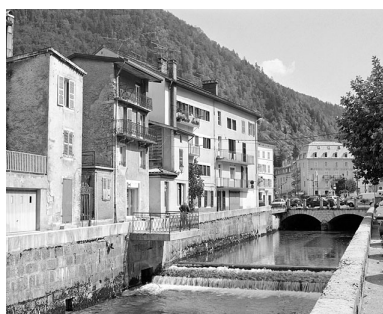
Immeubles aux n° 12 et 14 du Petit Quai, depuis l'ouest. Phot. Yves Sancey IVR43_20033900665X
