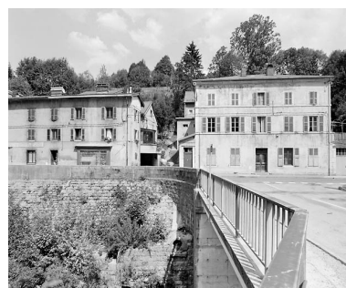
La rue de la République, au débouché du pont des Teppes (n° 33 et 35). Phot. Yves Sancey IVR43_20033900147X
