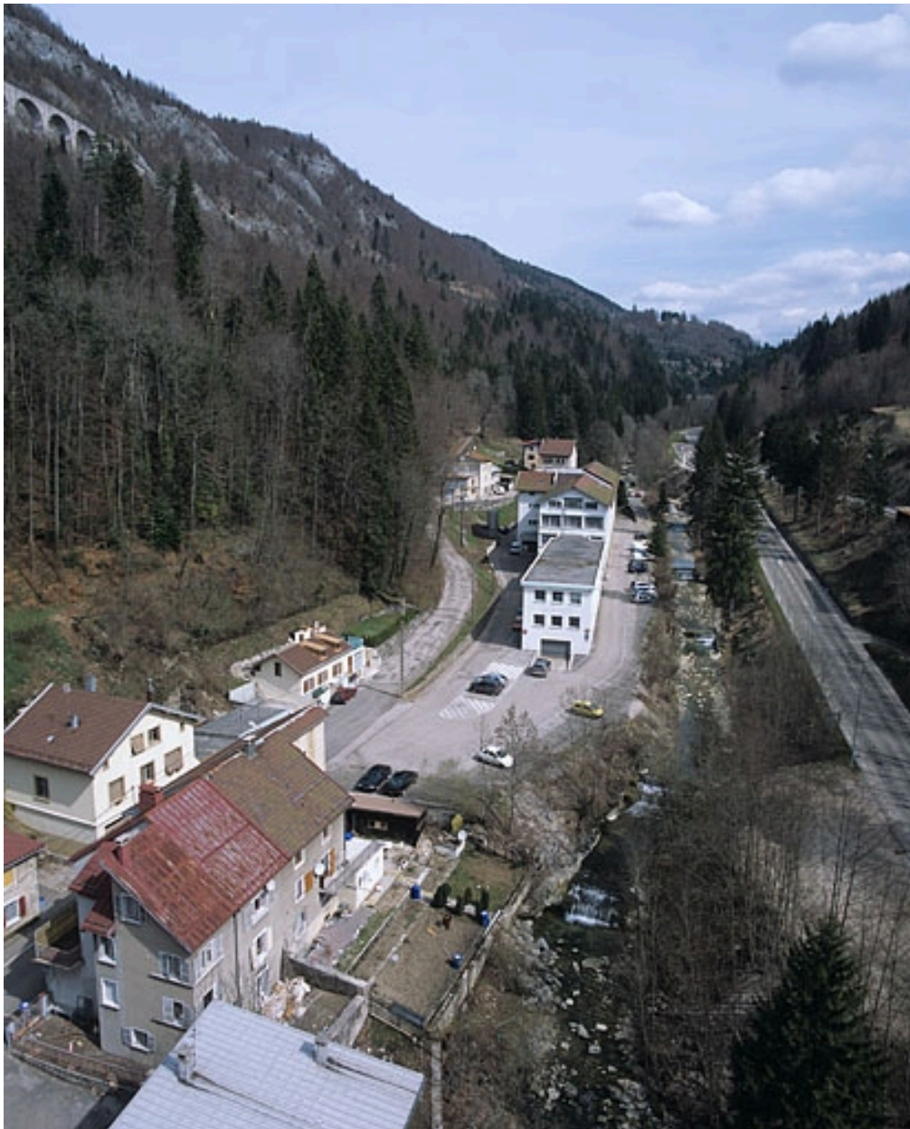
Le quartier de la cour du Roi et la vallée de l'Evalude, depuis le grand viaduc.
