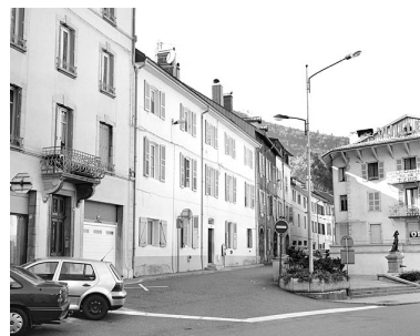
La rue Victor Hugo vers le n ° 32, près de son débouché sur la rue de la République. Phot. Yves Sancey IVR43_20033900432X
