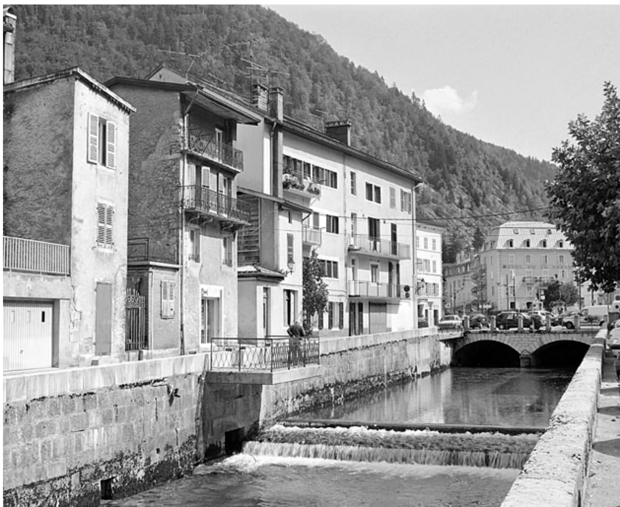
Immeubles aux n° 12 et 14 du Petit Quai, depuis l'ouest.
