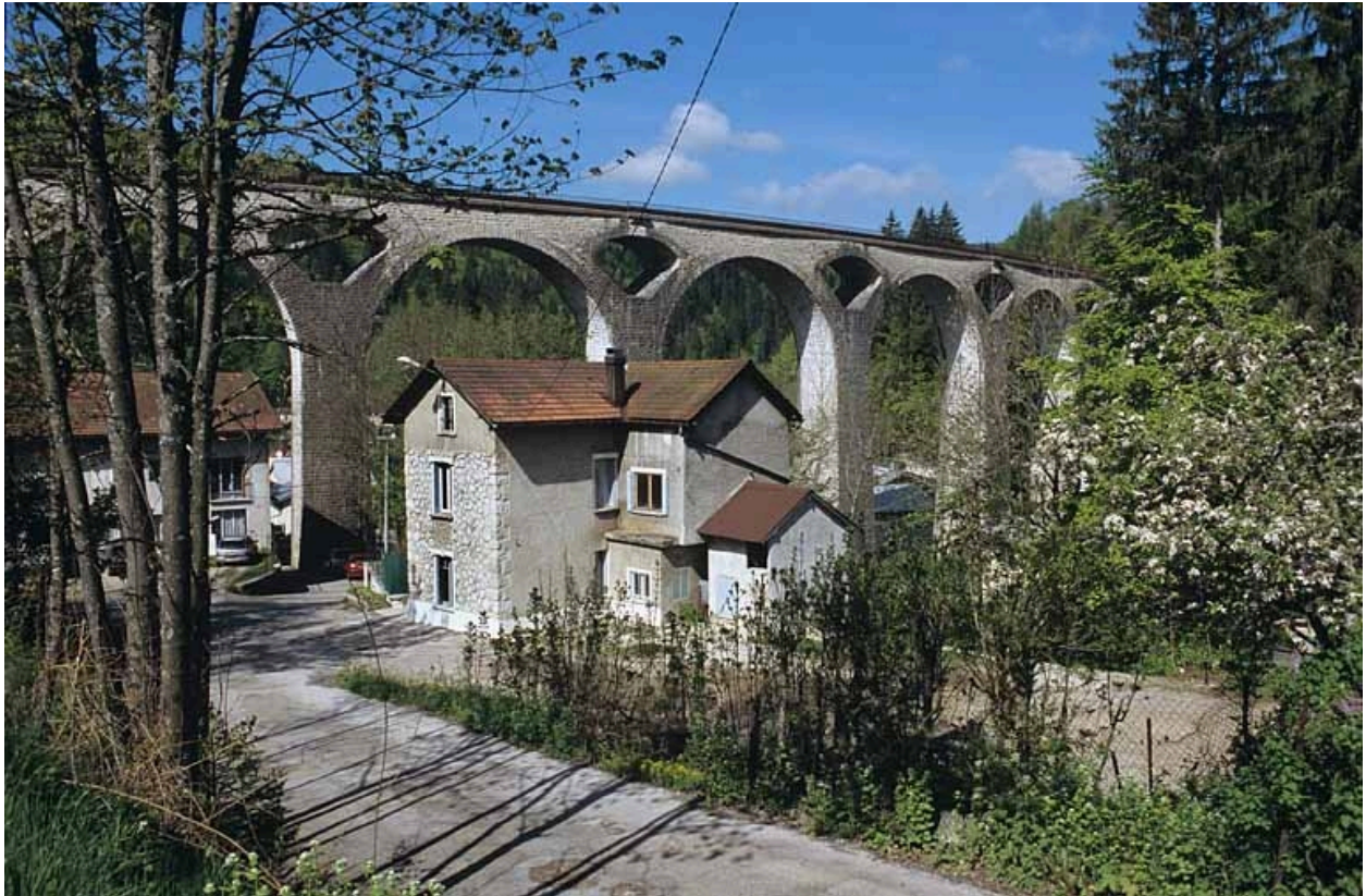
Le grand viaduc et une maison, vus du vallon de l'Evalude en amont.
