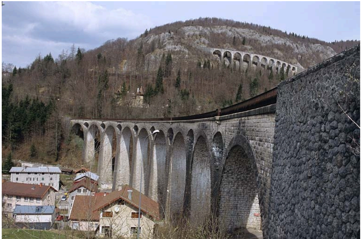
Le grand viaduc vu en enfilade, depuis l'extrémité côté gare.
