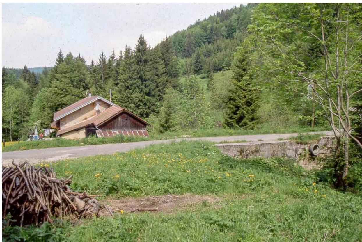
Emplacement du bassin de retenue.
