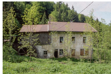
Façade postérieure. Phot. Yves Sancey IVR43_19993900169ZA
