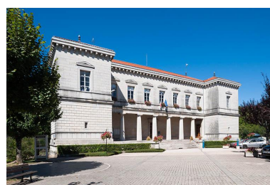
Vue générale sud-ouest Phot. Jérôme Mongreville IVR43_20137000278NUCA
