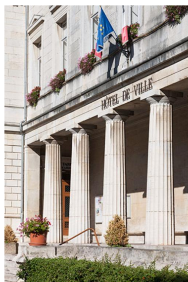
Vue sud-est du porche Phot. Jérôme Mongreville IVR43_20137000269NUCA
