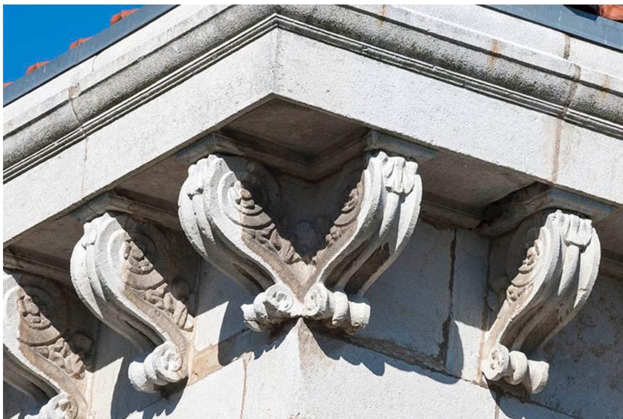
Détail de la corniche
