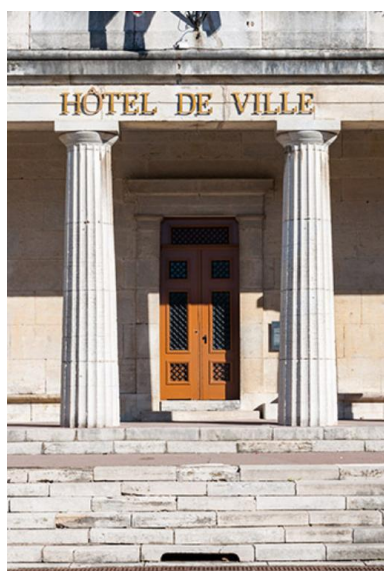
Partie centrale du porche Phot. Jérôme Mongreville IVR43_20137000267NUCA
