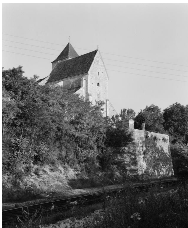
Vue d'ensemble, prise du canal.
