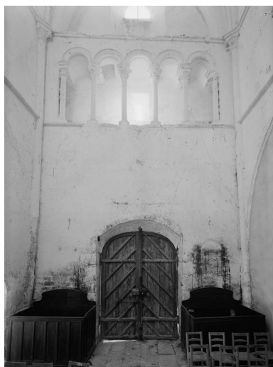
Revers de la façade. Phot. non renseigné IVR26_19728900251V
