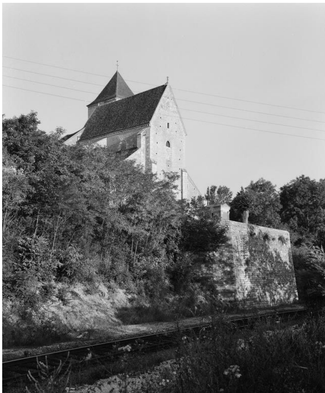
Vue d'ensemble, prise du canal.
