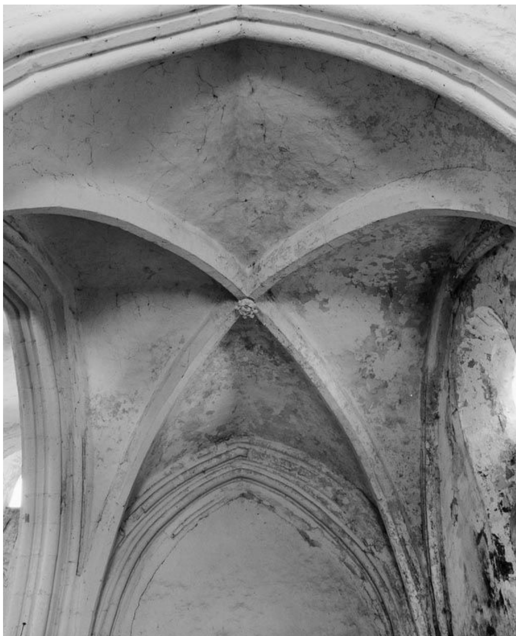
Collatéral gauche, 2 e travée : voûtement.
