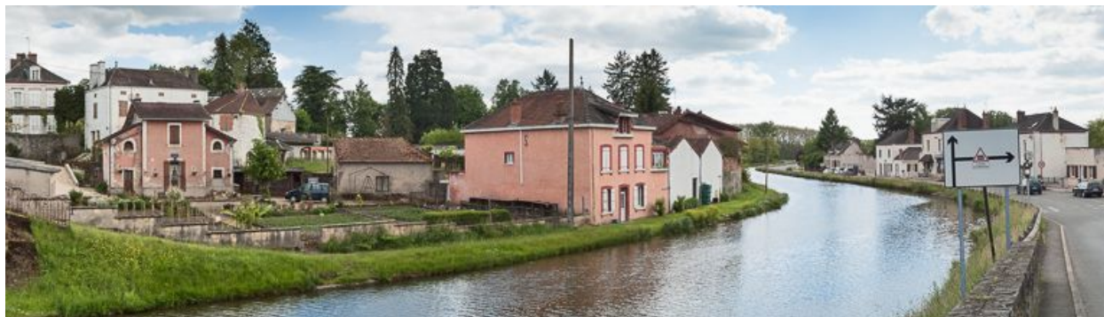
Vue depuis la rive droite.
