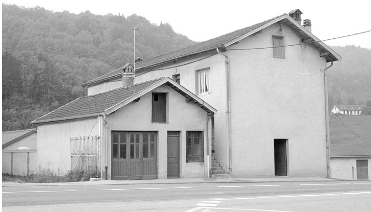
Façades sur rue.
