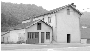
Façades sur rue.
