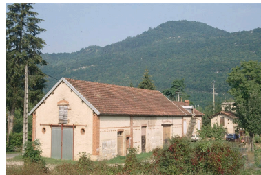
Ferme du moulin de Marignat : les dépendances agricoles. Phot. Laurent Poupard IVR43_19903900501ZA
