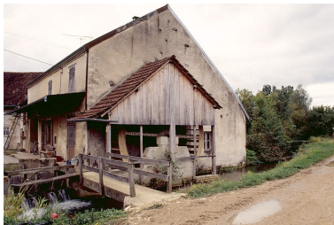
Façade latérale depuis l'est. Phot. Jérôme Mongreville IVR43_19953900430ZA
