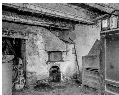
Le four au rez-de- chaussée de l'habitation.
