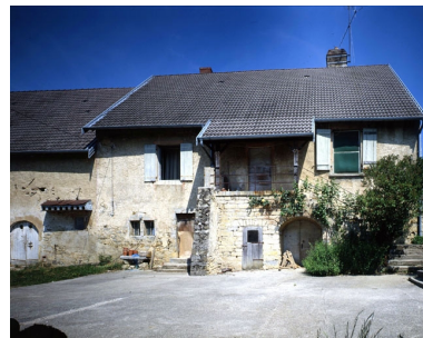
Façade antérieure. Phot. Yves Sancey IVR43_19903901167VA
