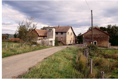
Vue d'ensemble. Phot. Jérôme Mongreville IVR43_19953900404ZA
