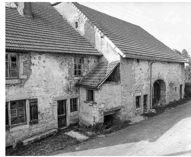
Maison cadastrée 1956 G1 182 Phot. Yves Sancey IVR43_19777000419X
