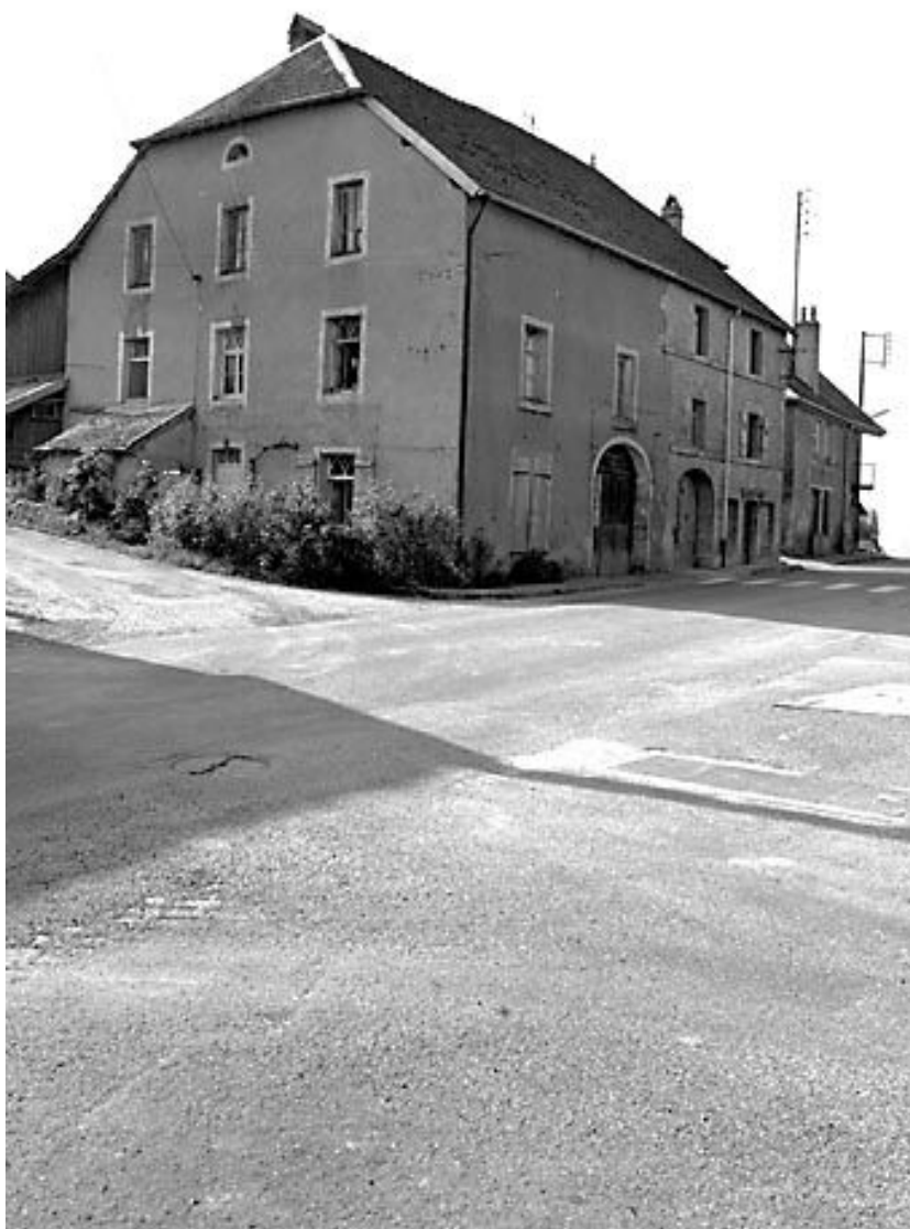
Maison située rue de la Tuilerie.
