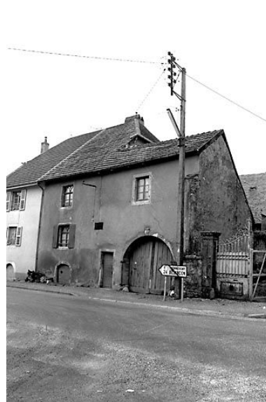
Ferme située 42 Grande Rue. Phot. Dominique Dominguez IVR43_19807000329X
