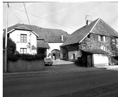
Ferme située 5 Grande Rue. Phot. Dominique Dominguez IVR43_19807000320X
