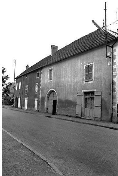
Ferme située 22 Grande Rue. Phot. Dominique Dominguez IVR43_19807000332X
