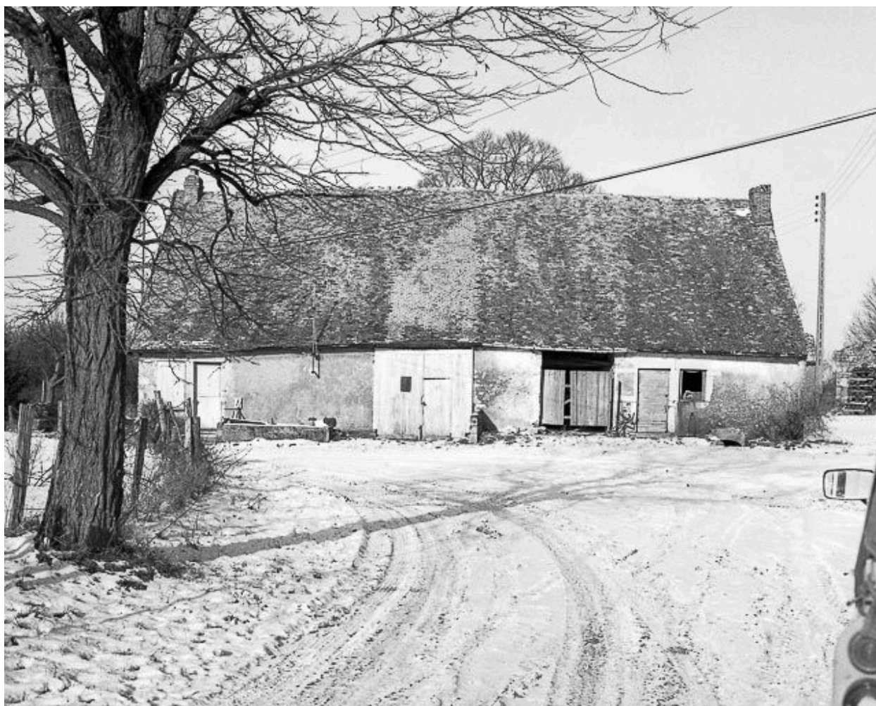
Ferme située à Grachaux, cadastrée 1956 E3 152
