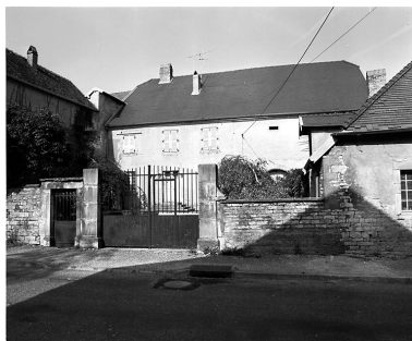
Ferme située 7 Grande Rue. Phot. Dominique Dominguez IVR43_19807000340X
