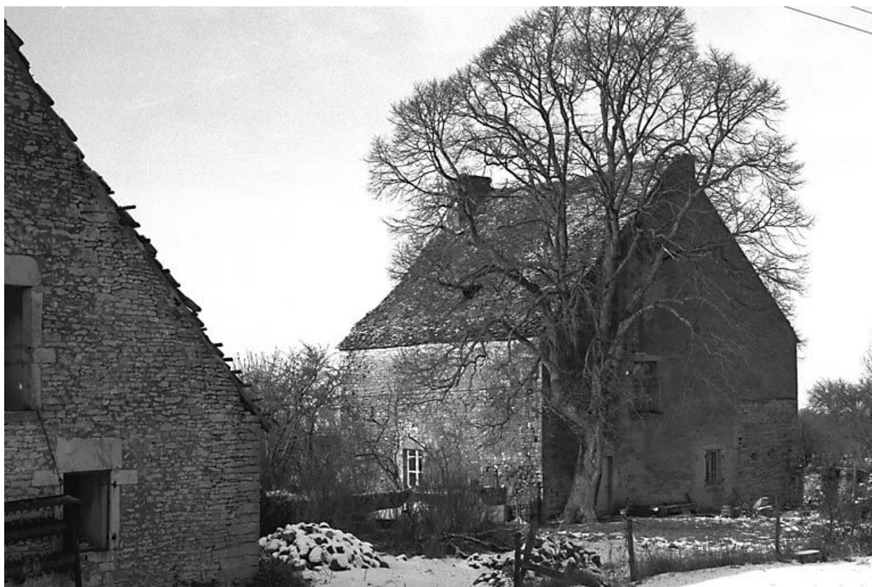
Ferme située à Grachaux
