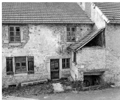
Maison cadastrée 1956 G1 182 Phot. Yves Sancey IVR43_19777000420X
