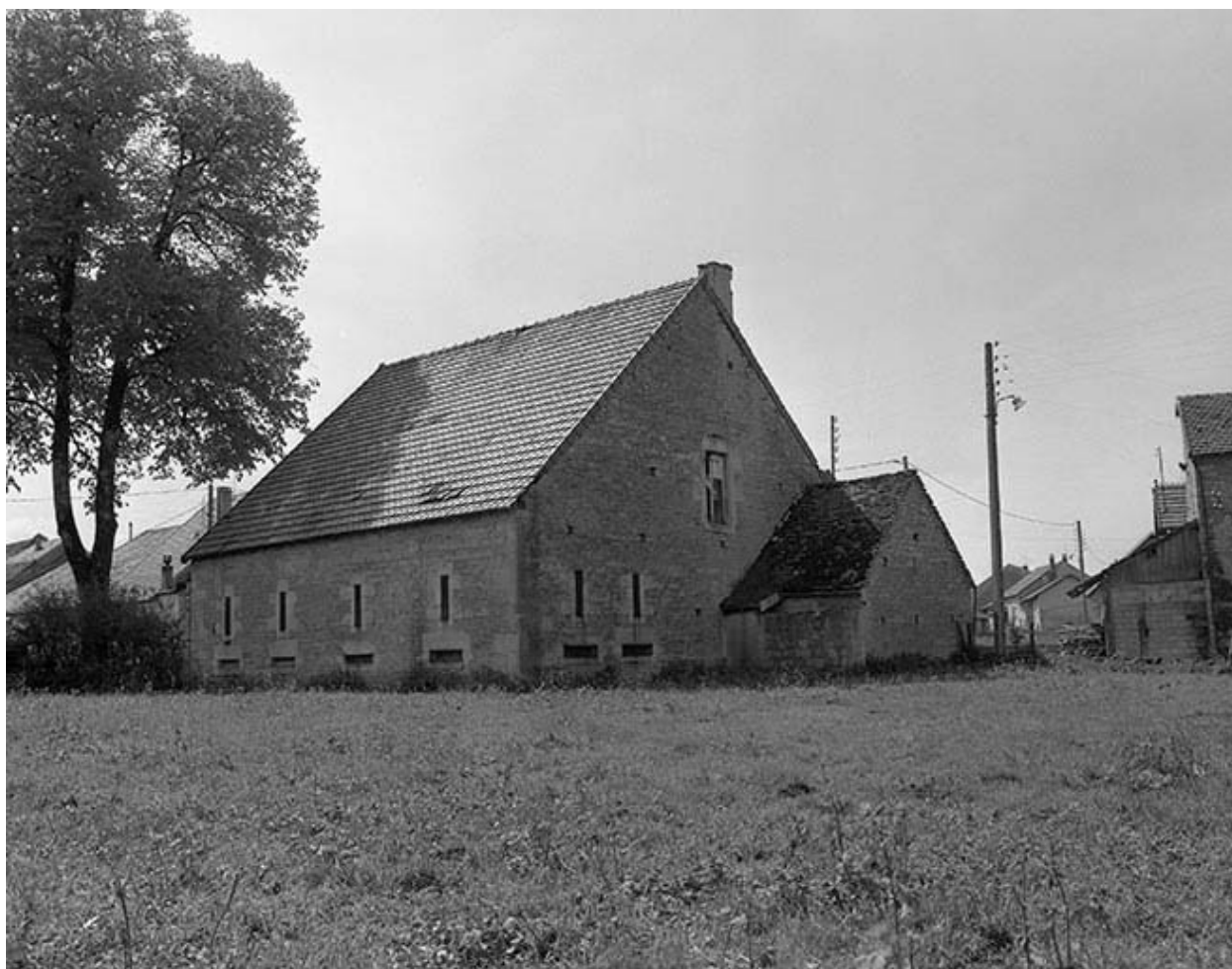
Façade postérieure et façade gauche.
