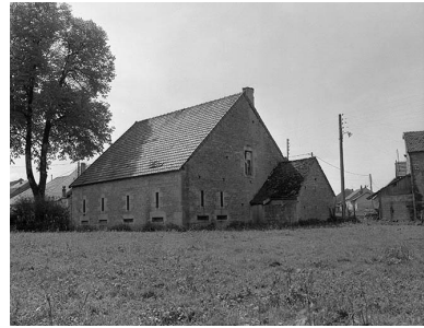
Façade postérieure et façade gauche. Phot. Jérôme Mongreville IVR43_19813900161X
