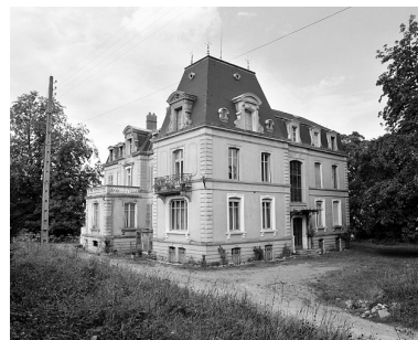
Vue de trois quarts en 1981.SRI. Enquête régionale sur les bâtiments industriels (1979-1981). Phot. Yves Sancey IVR43_19819000072X
