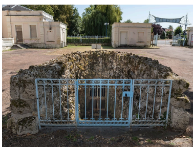
Escalier de la source, détail.
