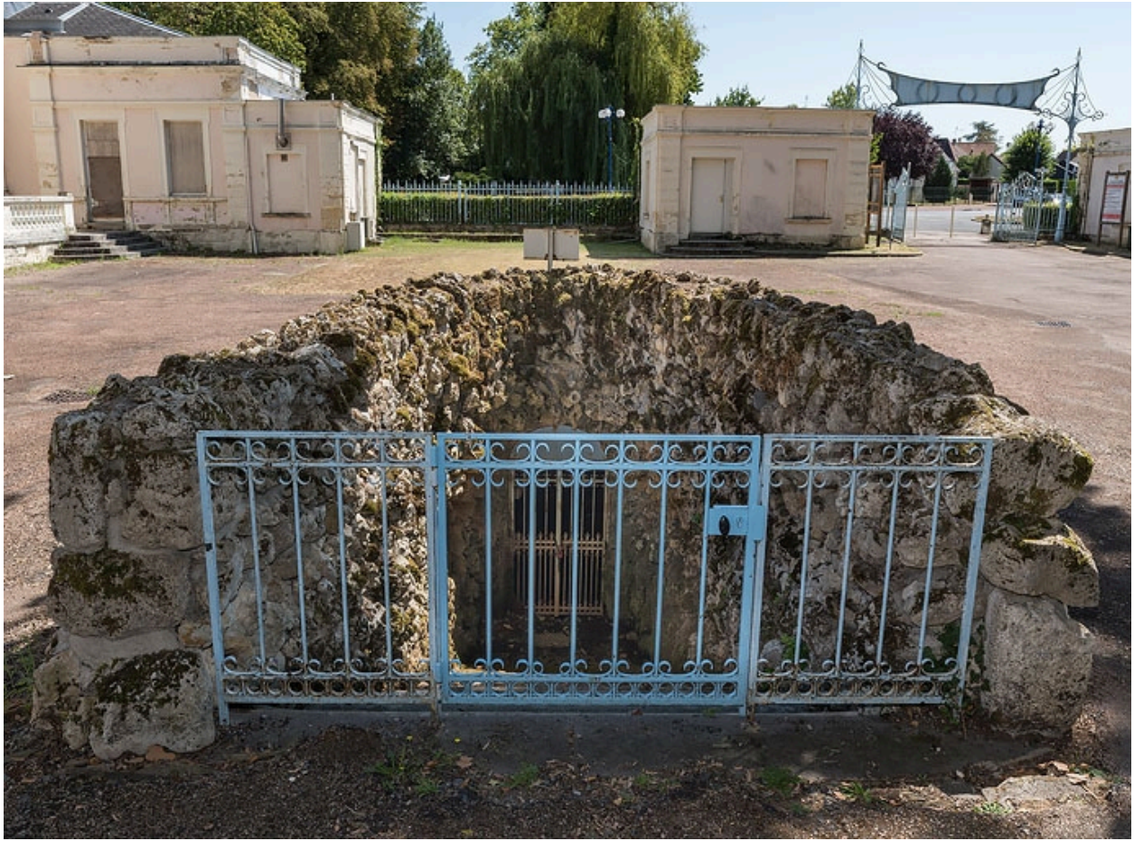
Escalier de la source, détail.
