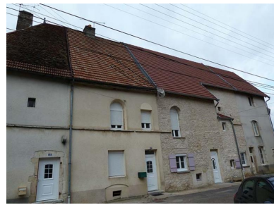
Vue générale sud-ouest Phot. Sabrina Dalibard IVR43_20137000876NUC2A
