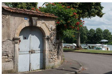
Portail, Grande rue du Bourg, et la Saône en arrière plan. Phot. Jérôme Mongreville IVR43_20187000292NUC4A
