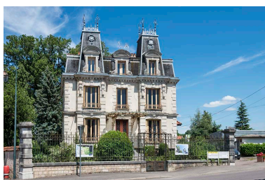
Demeure n°1 rue des Vignes. Phot. Jérôme Mongreville IVR43_20187000479NUC4A
