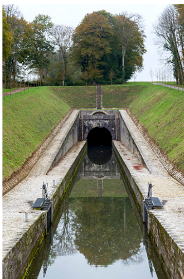
Entrée amont du tunnel de Saint-Albin. Phot. Sonia Dourlot IVR43_20157000209NUC2A
