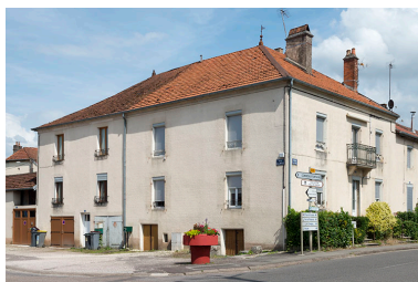
Ancienne teinturerie, avenue des Pâtis. Phot. Jérôme Mongreville IVR43_20187000387NUC4A
