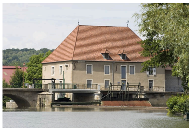
Centrale hydroélectrique. Phot. Jérôme Mongreville IVR43_20087000884NUC2A
