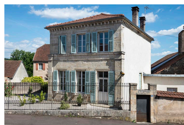
Ancienne école des filles, quartier de l'église. Phot. Jérôme Mongreville IVR43_20187000336NUC4A
