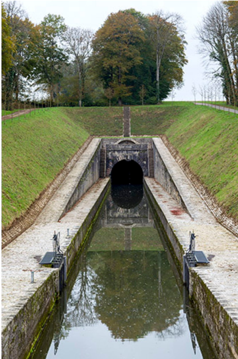
Entrée amont du tunnel de Saint-Albin.
