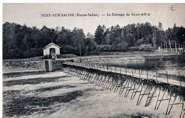
Le barrage à aiguilles de Saint-Albin, carte postale. Phot. Jérôme Mongreville IVR43_20197000066NUC4A
