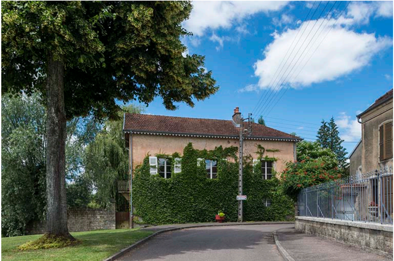
Ancienne tannerie, grande rue du Bourg.
