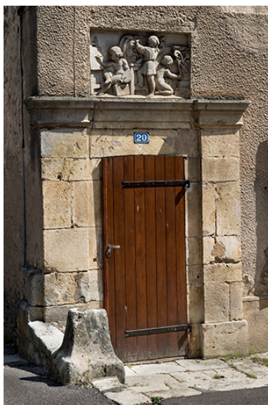
Maison Lempereur, rue de l'Eglise. Phot. Jérôme Mongreville IVR43_20187000503NUC4A
