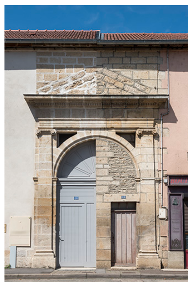
Maison commune, justice de paix, école et halle de la première moitié du 19e siècle. Phot. Jérôme Mongreville IVR43_20187000421NUC4A
