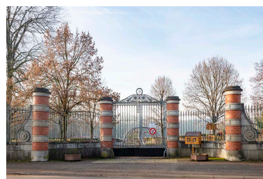
Clôture (grille) sur l'avenue des Pâtis de l'ancien château. Phot. Jérôme Mongreville IVR43_20197000101NUC4A
