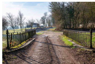
Pont franchissant la tranchée de la voie ferrée (aujourd'hui comblée) dans le quartier de l'Église. Phot. Jérôme Mongreville IVR43_20197000110NUC4A
