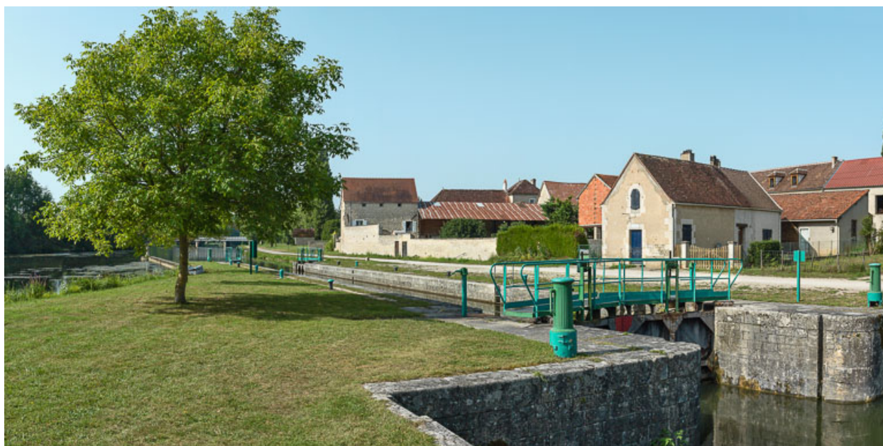
Vue du site d'écluse.
