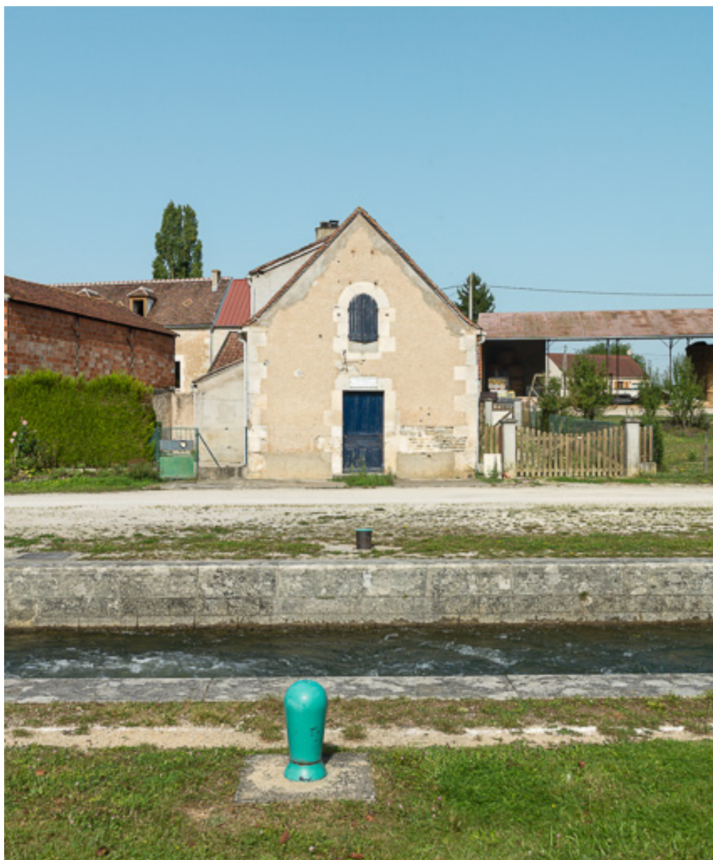
Vue de la maison éclusière.
