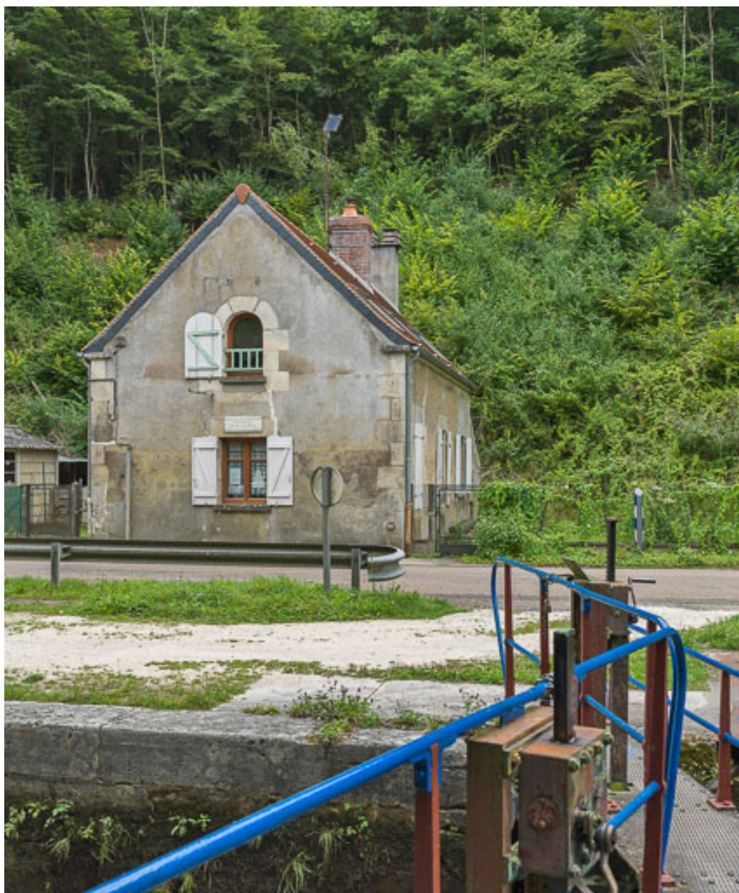
Vue de la maison éclusière.
