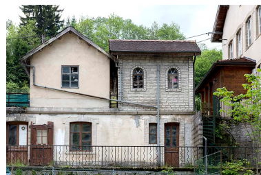
Atelier, garage et dépendance, depuis le nord.
