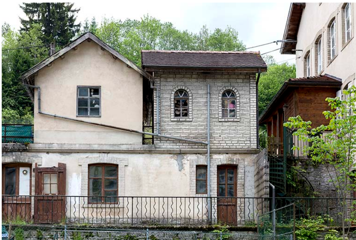
Atelier, garage et dépendance, depuis le nord.
