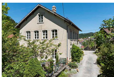
Maison : façade ouest.
