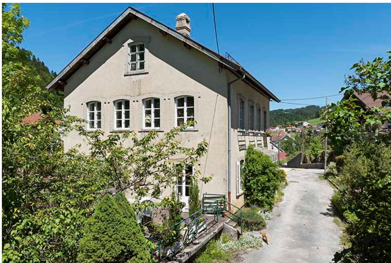
Maison : façade ouest.
