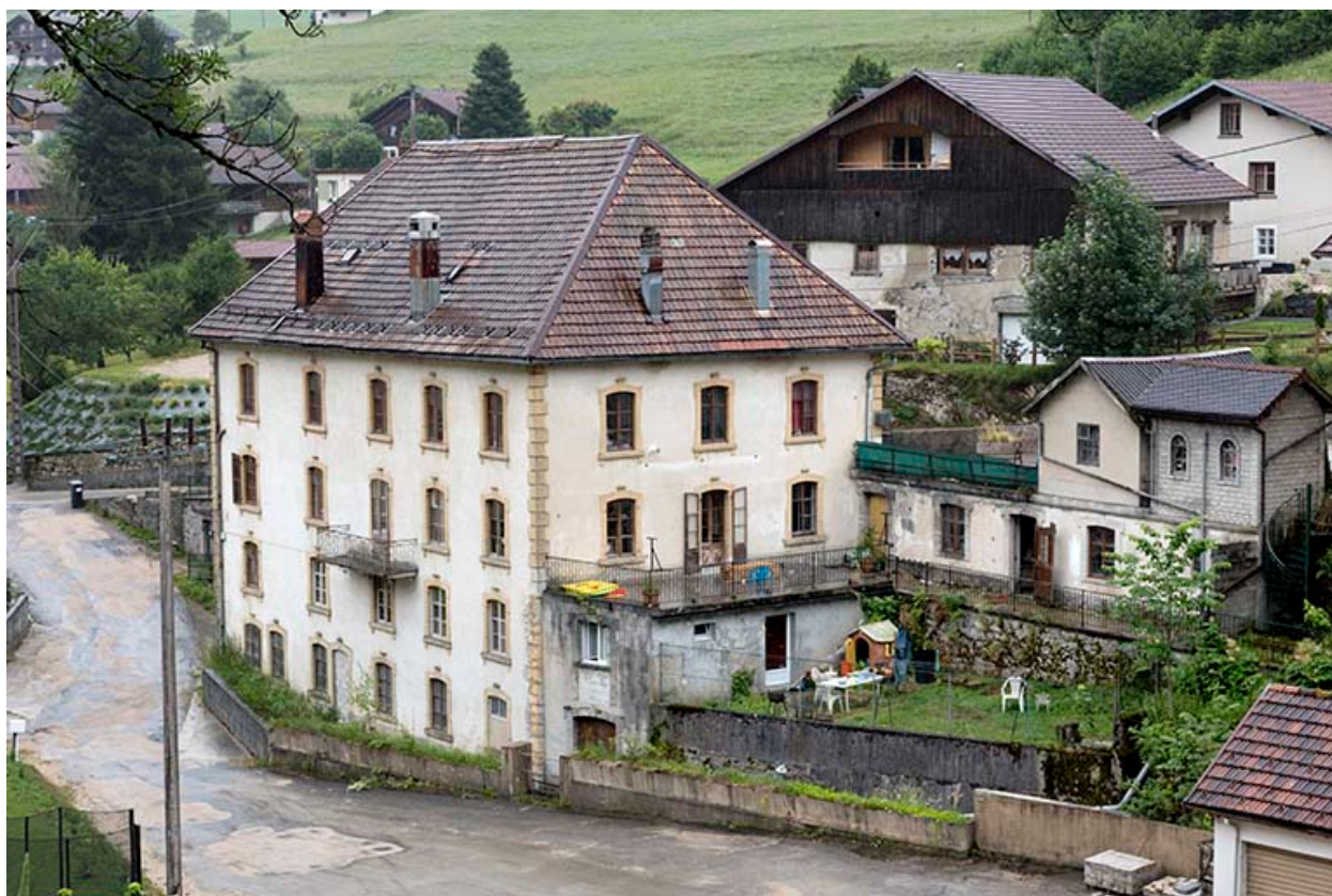
Immeuble et dépendance, depuis le nord-ouest.
