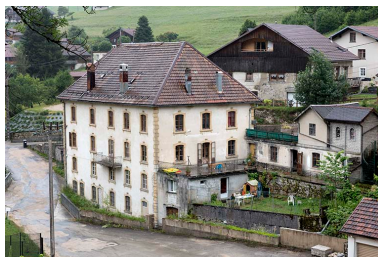
Immeuble et dépendance, depuis le nord-ouest.
