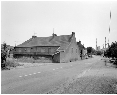
Logements d'ouvriers (7), vus de trois quarts droit. Phot. Yves Sancey IVR43_19893901036X
