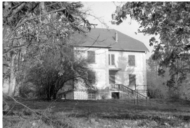
Logement patronal (14). Phot. Laurent Poupard IVR43_19893901051Z
