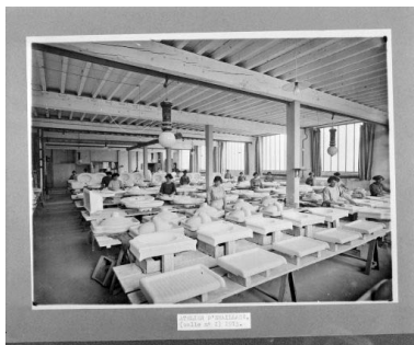
L'atelier d'émaillage, salle n° 1 (bâtiment 46). Phot. Jérôme Mongreville IVR43_19903900354X
