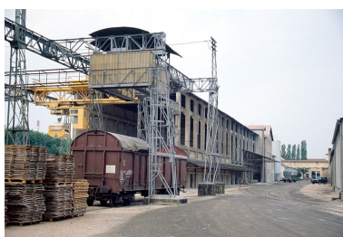
Pont roulant et hangar à terre (18). Phot. Laurent Poupard IVR43_19893901026ZA
