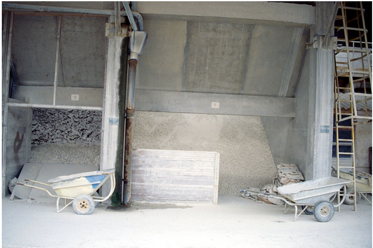
Hangar à terre (18) : détail des silos ouverts.
