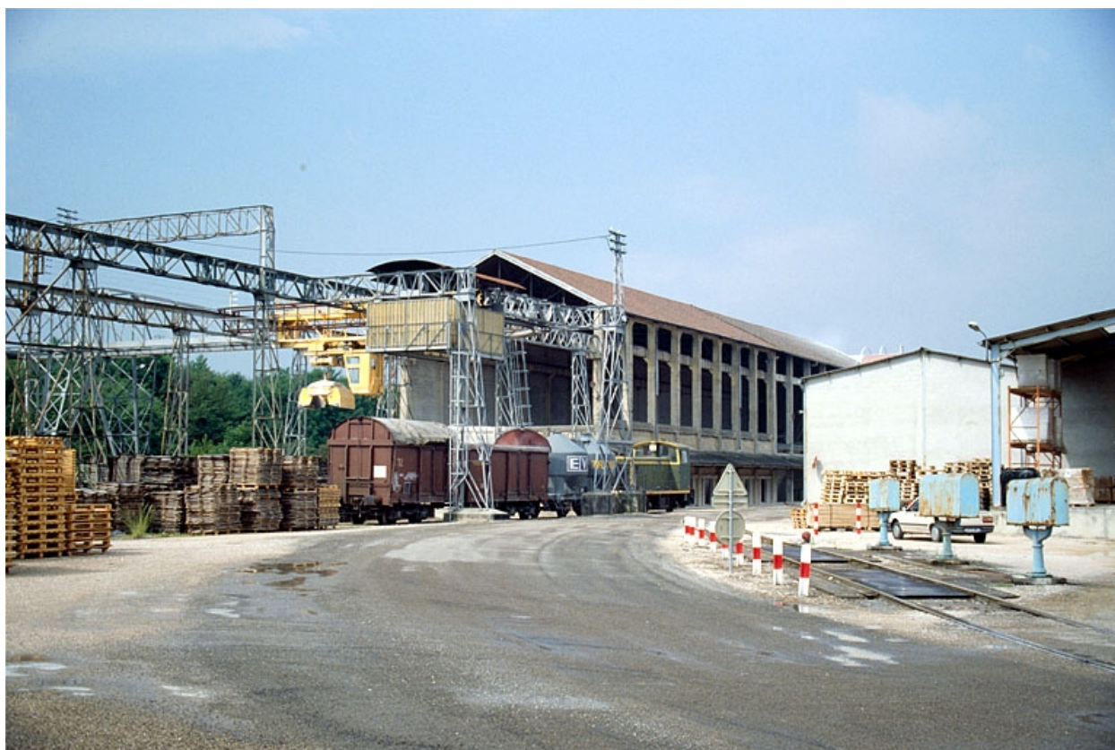
Pont-bascule (40), pont roulant (17) et hangar à terre (18).
