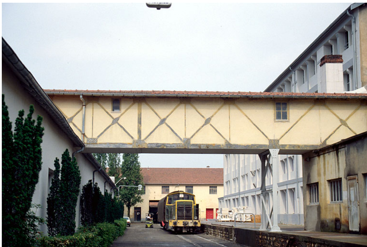
Façade antérieure de l'atelier (42), passerelle et locomotive.
