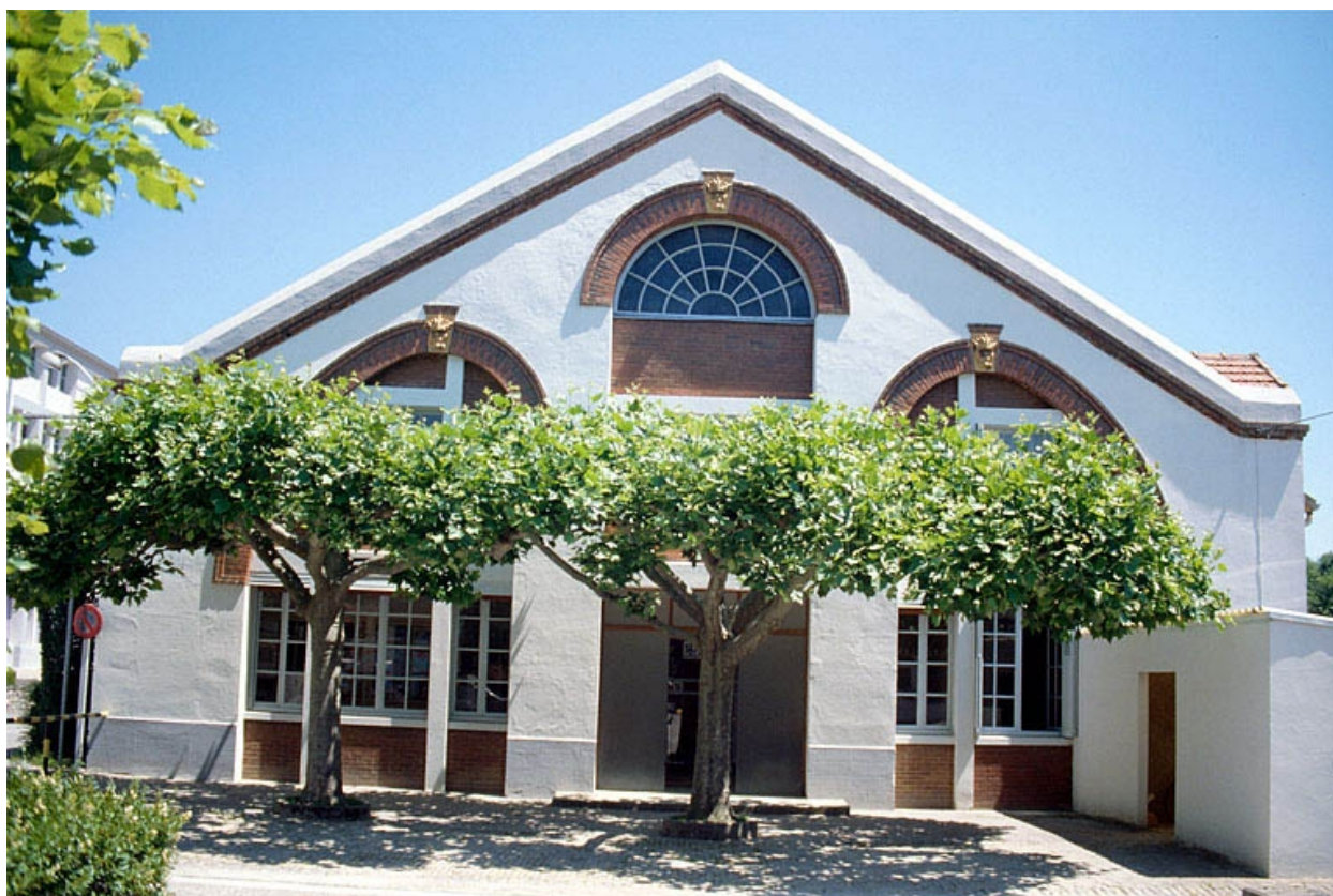
Façade antérieure des bureaux, vue de face.
