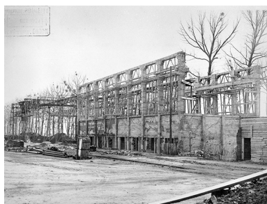
Hangar à terre (18) en construction. Phot. Yves Sancey, Autr. Art et Photo IVR43_19893900654X
