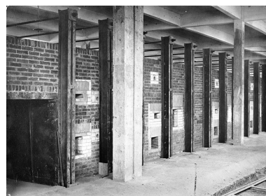
Four Dressler en construction : vue latérale. Phot. Yves Sancey IVR43_19893900656X
