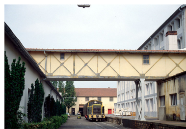
Façade antérieure de l'atelier (42), passerelle et locomotive. Phot. Laurent Poupard IVR43_19893901012ZA
