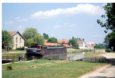
Vue d'ensemble de l'usine, depuis l'écluse. Phot. Laurent Poupard IVR43_19893901000ZA
