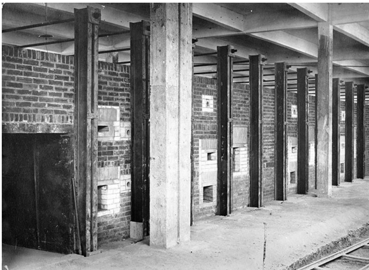
Four Dressler en construction : vue latérale.
