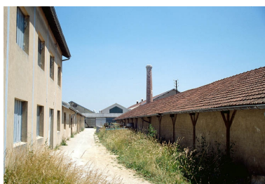
Passage entre deux bâtiments. Phot. Laurent Poupard IVR43_19893901020ZA
