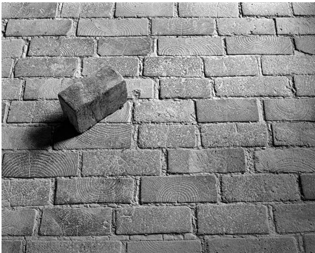
Hangar à terre (25) : détail du pavement en bois.
