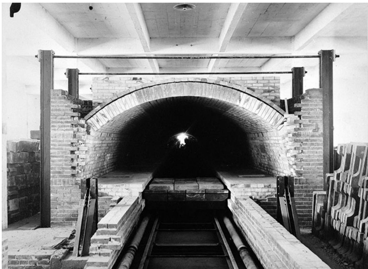
Four Dressler en construction : vue de face.
