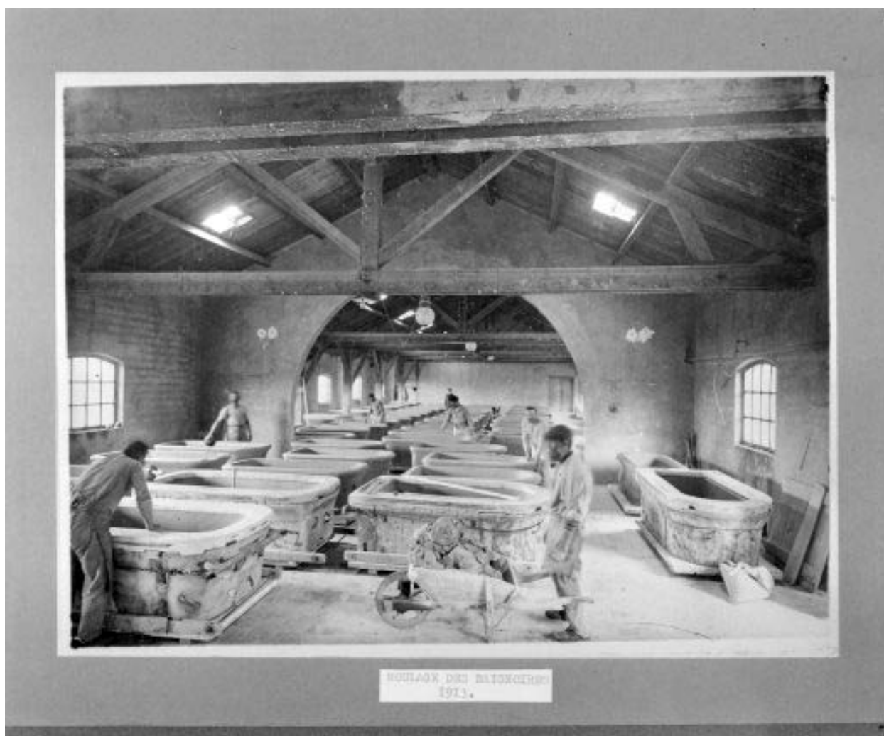
Le moulage des baignoires (bâtiment 42).
