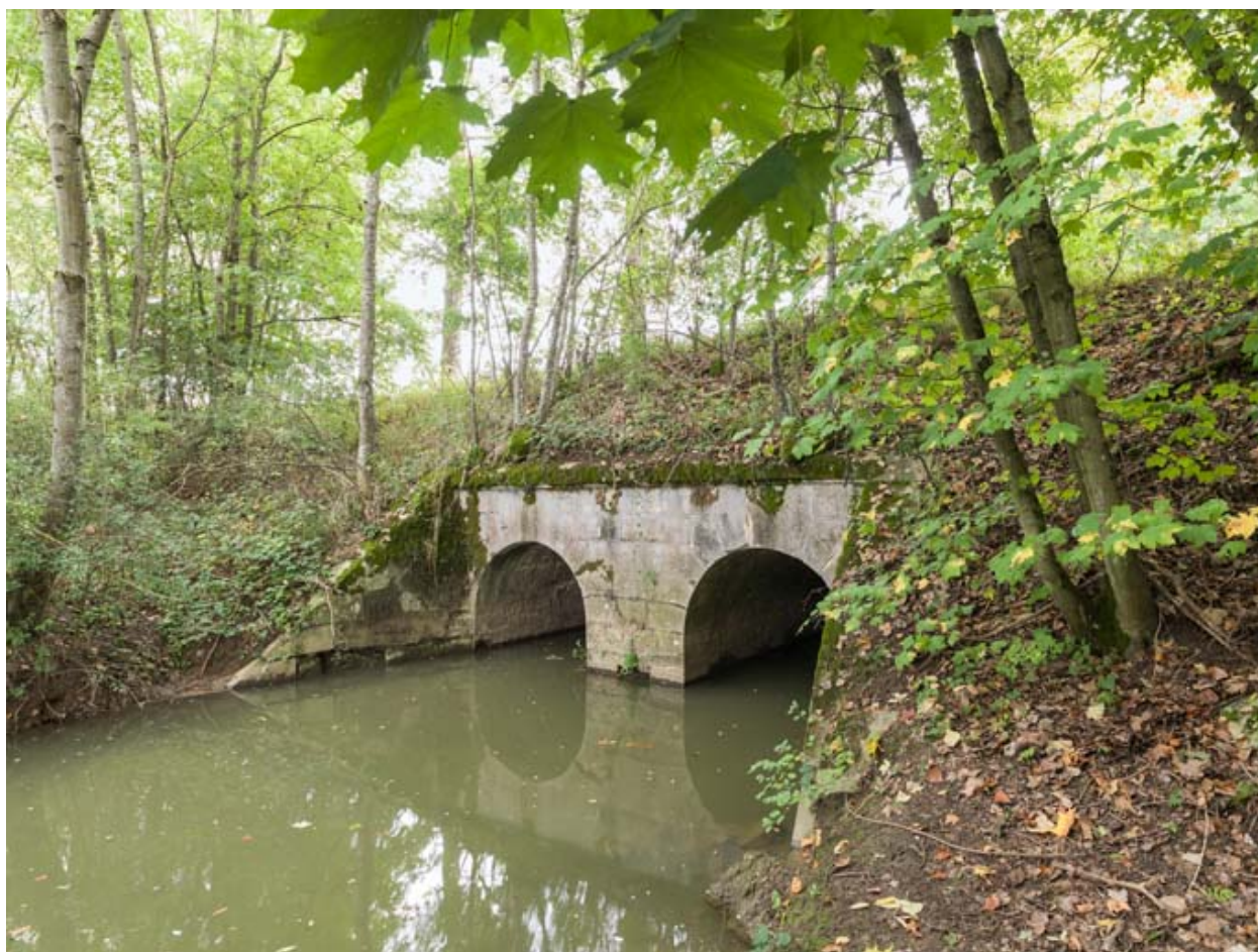
Vue de l'aqueduc.
