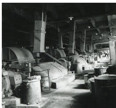
Atelier des piles (raffinage), photogr., s.d. [3e quart 20e siècle]. IVR43_20152501949NUC4A
