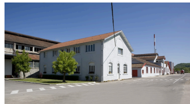
Bureaux et ateliers de réparation et de maintenance. Façades sud.
