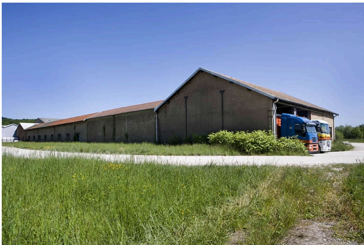
Magasin industriel. Pignon ouest.
