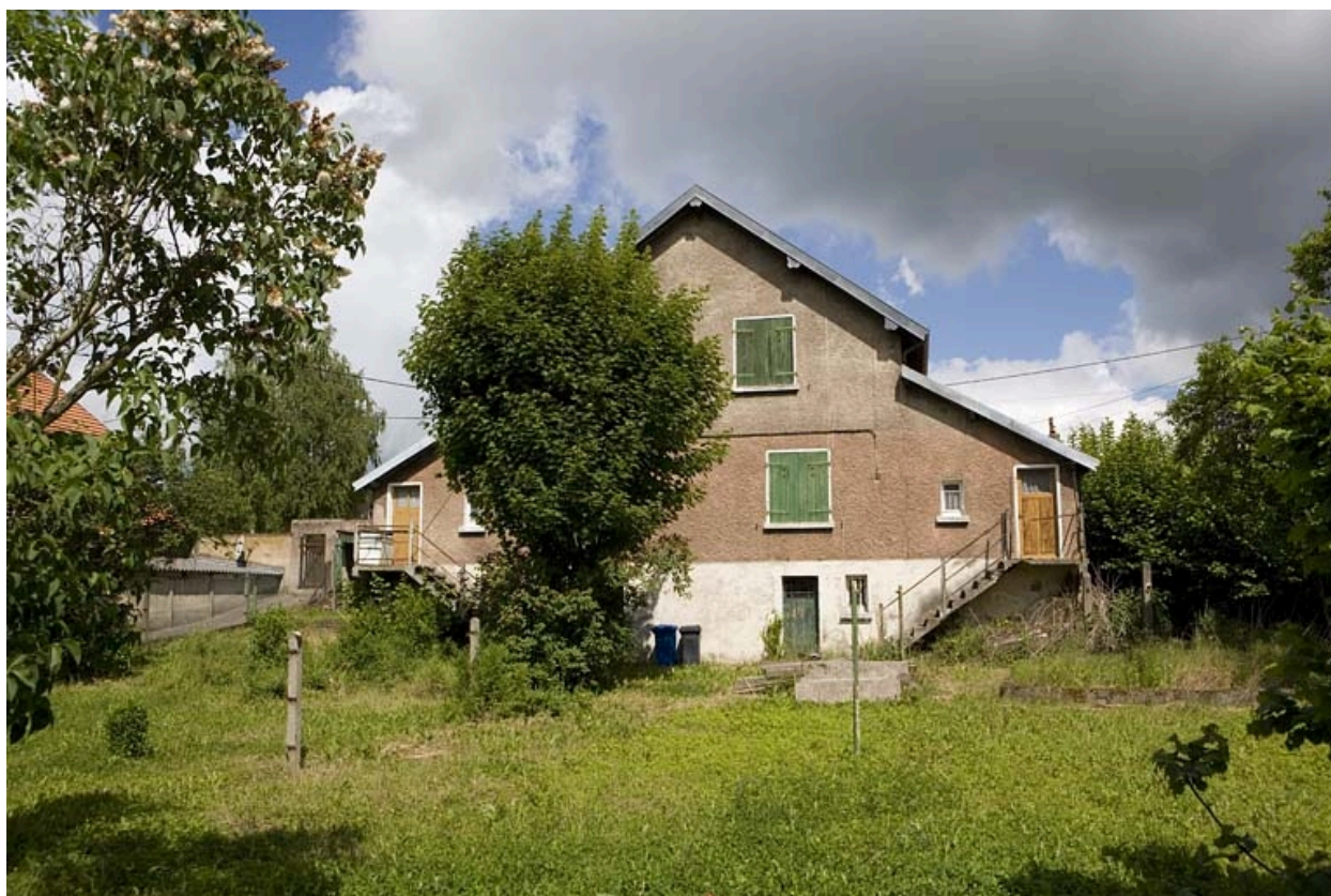
Cité Lehmann. Façade postérieure d'une maison.
