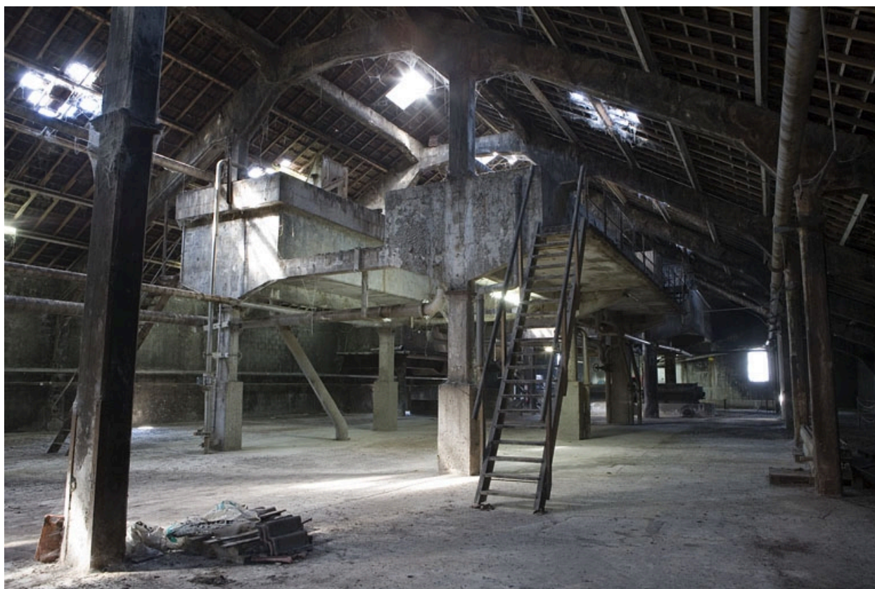
Atelier de trituration. Vue d'ensemble du second étage.
