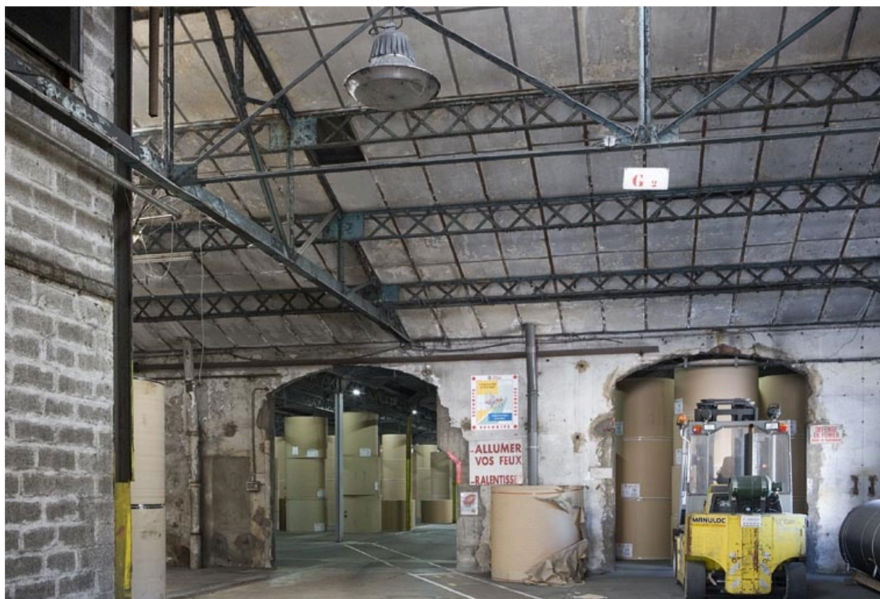
Magasin industriel. Charpente métallique avec poutrelles à treillis.
