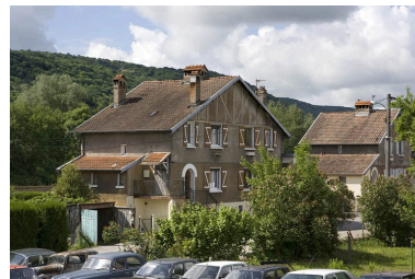
Place de Chemontey. Façade antérieure d'une maison.
