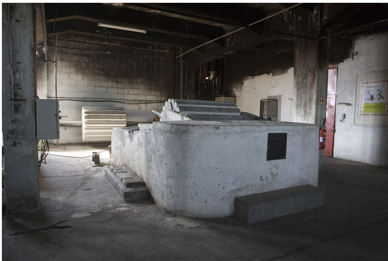
Pile raffineuse. Vue arrière.
