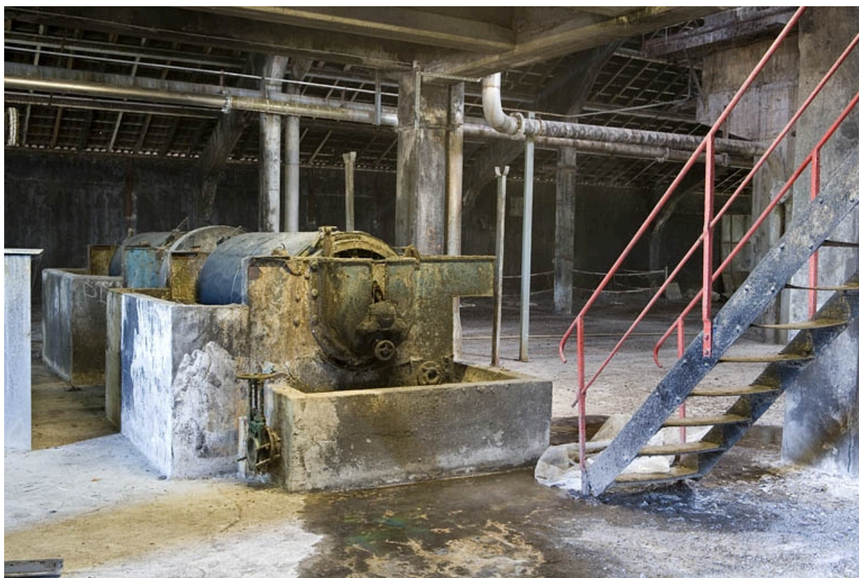
Atelier de trituration. Vue rapprochée du mélangeur à acides (?).
