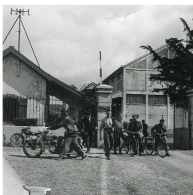
Sortie de l'usine, photogr., s.d. [3e quart 20e siècle]. IVR43_20152501947NUC4A
