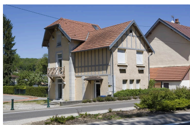
Conciergerie du logement patronal. Façade sur cour. Phot. Yves Sancey IVR43_20092500569NUC2A
