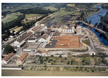
Vue aérienne, depuis l'ouest. Phot. Yves Sancey IVR43_20092500586NUC2A
