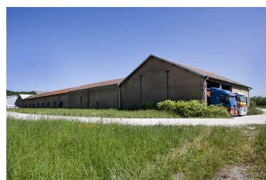
Magasin industriel. Pignon ouest.
