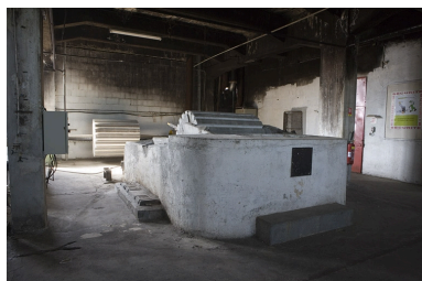
Pile raffineuse. Vue arrière.
