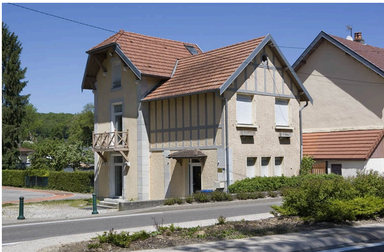
Conciergerie du logement patronal. Façade sur cour.
