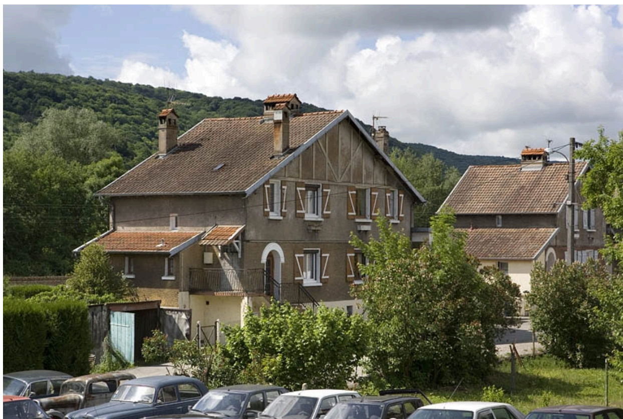
Place de Chemontey. Façade antérieure d'une maison.
