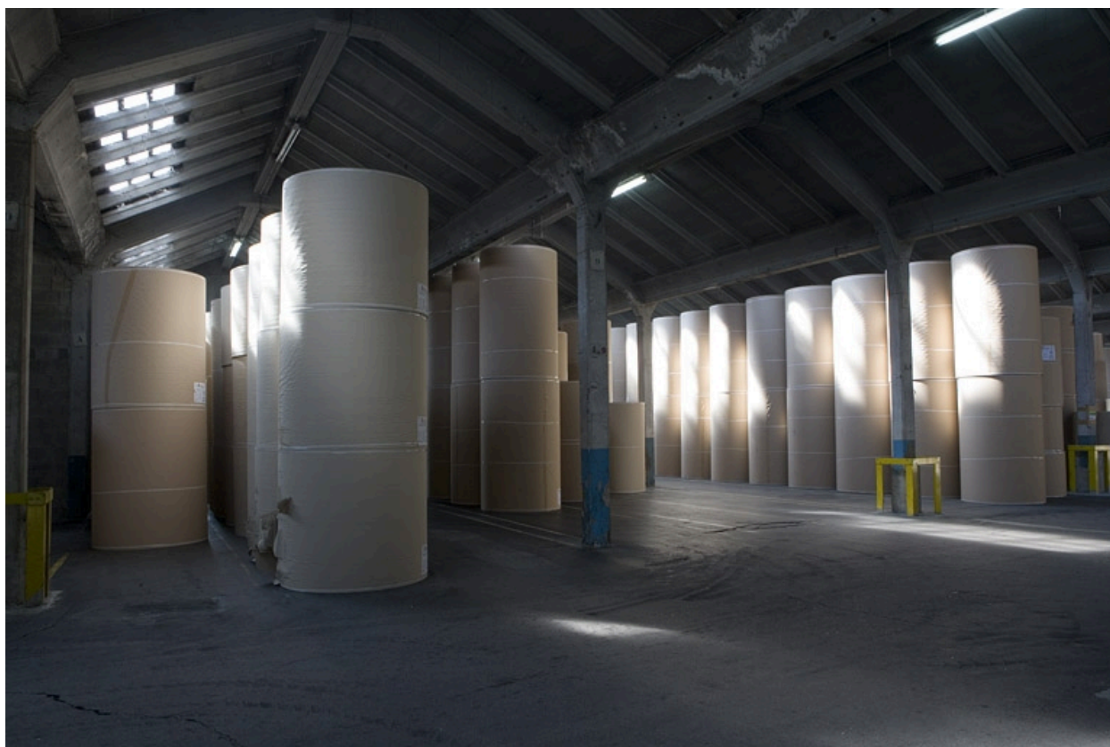
Magasin industriel. Stockage des bobines.
