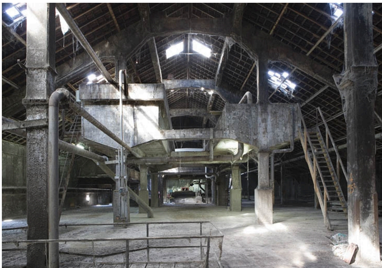
Atelier de trituration. Vue d'ensemble dans l'axe du bâtiment, depuis le sud.
