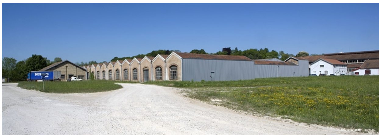
Magasin industriel depuis le sud-est.
