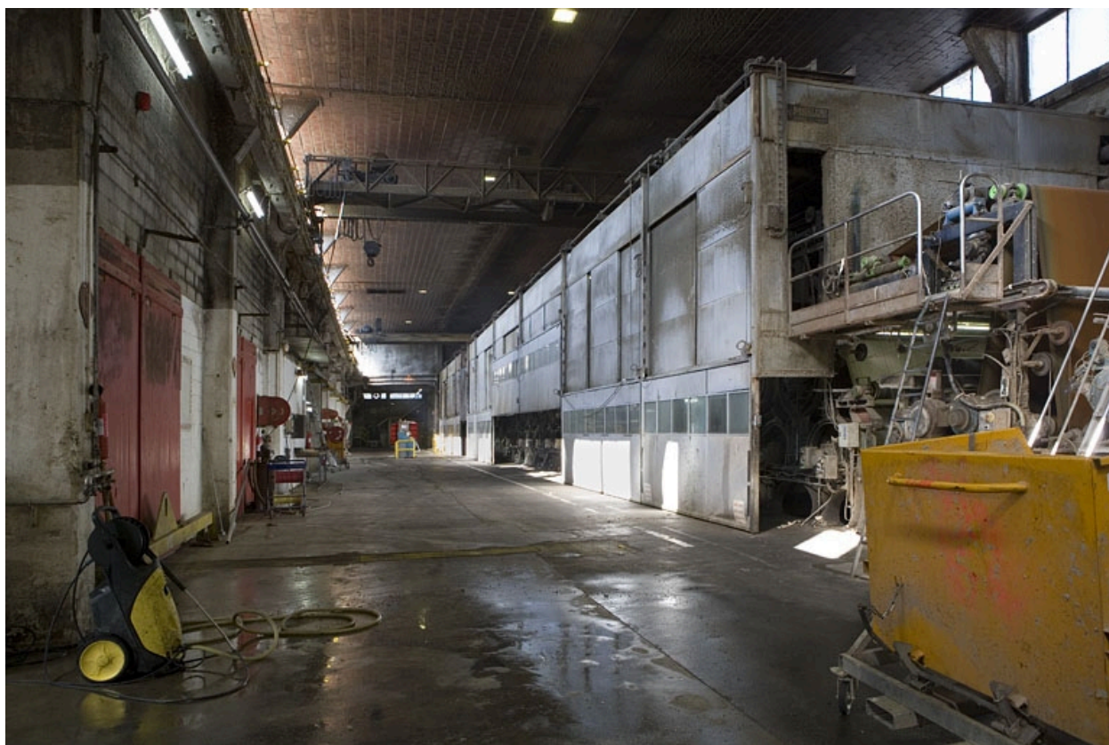
L'atelier de la machine à papier. La sécherie depuis l'est.
