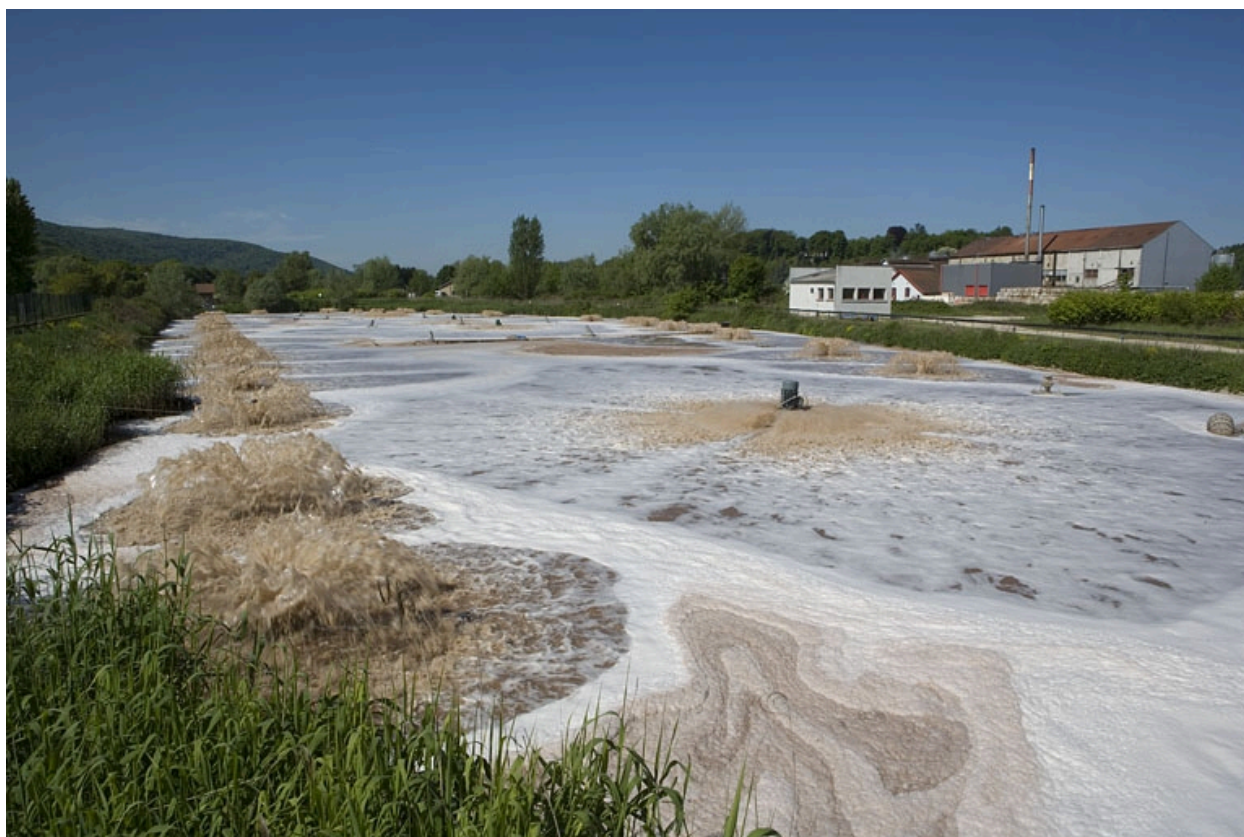
Bassin de décantation et atelier de trituration. Vue depuis le sud-est.
