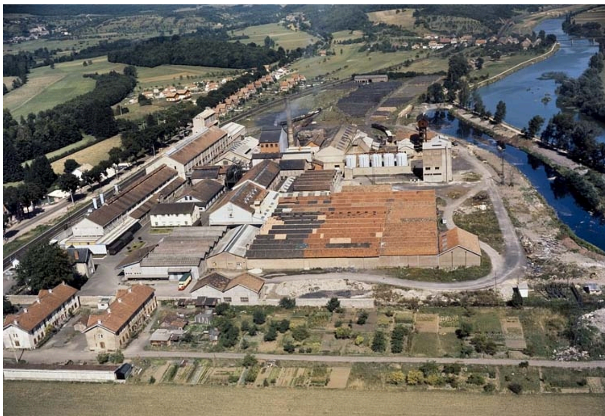
Vue aérienne, depuis l'ouest.
