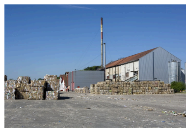
Aire des matières premières et atelier de trituration depuis le nord-est.
