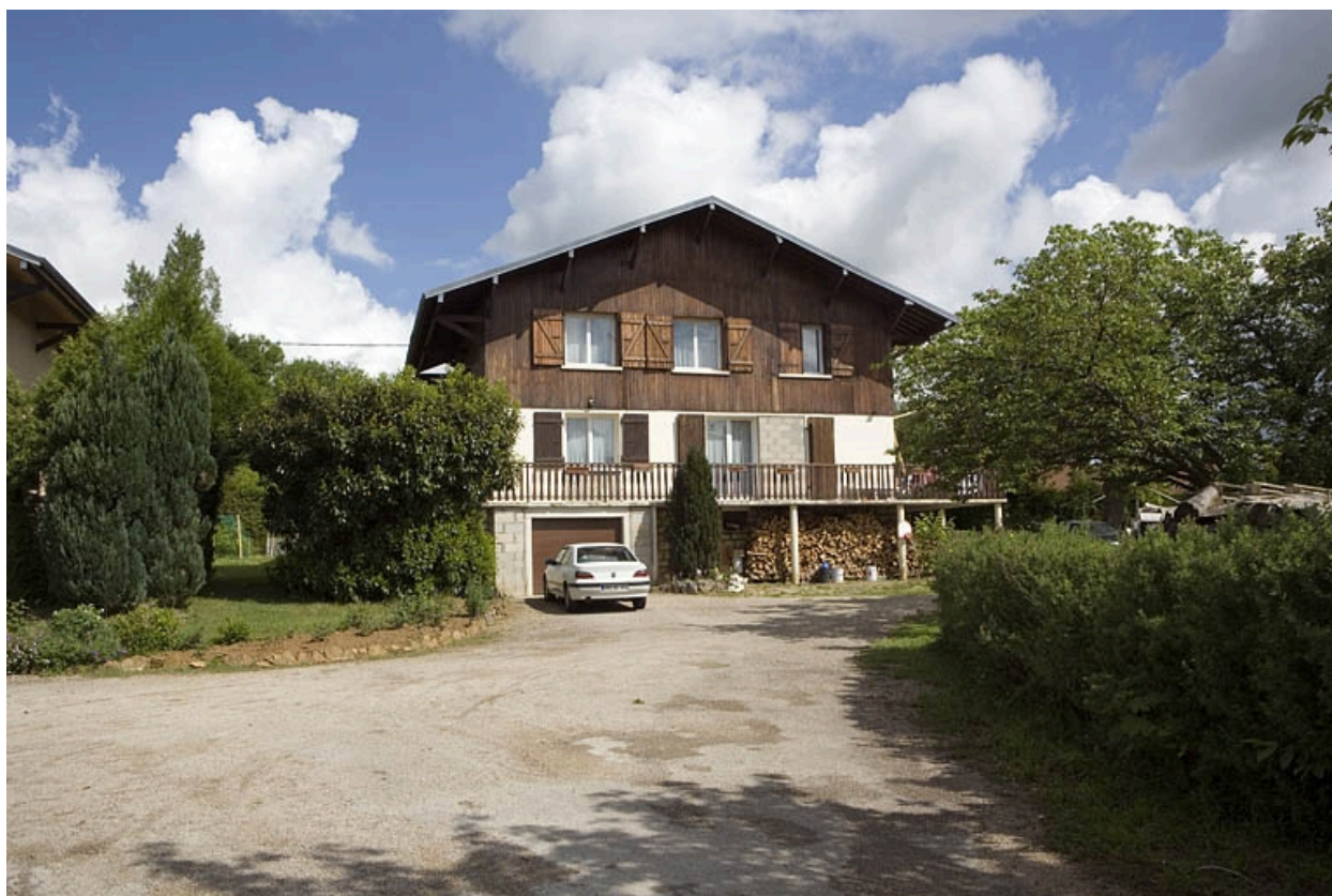
Maison de direction. Façade antérieure.
