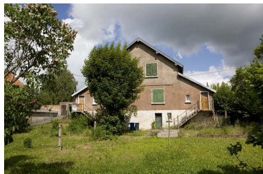
Cité Lehmann. Façade postérieure d'une maison.
