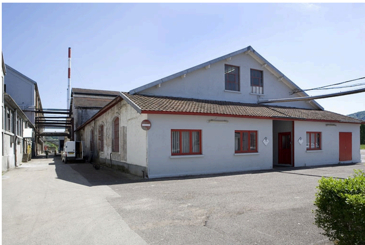
Atelier de réparation et de maintenance. Vue de trois quarts arrière.
