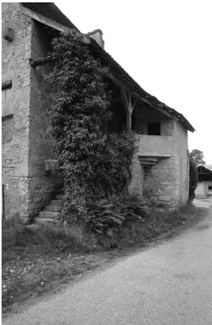
Détail de l'escalier extérieur sur façade antérieure.
