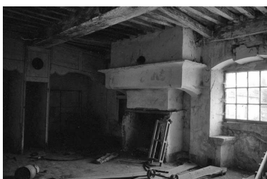
Intérieur : vue de la cheminée.
