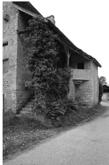
Détail de l'escalier extérieur sur façade antérieure.
