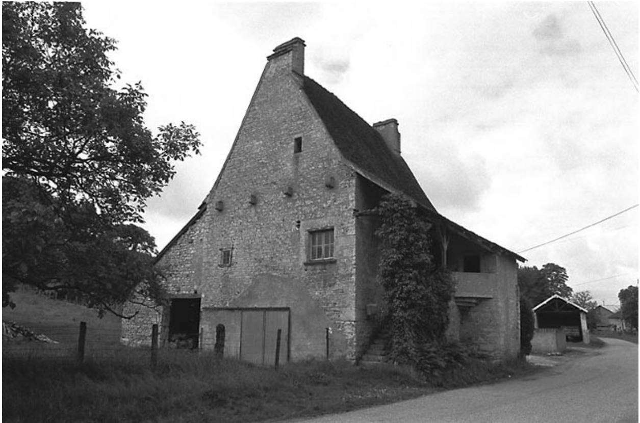
Façades antérieure et latérale gauche.
