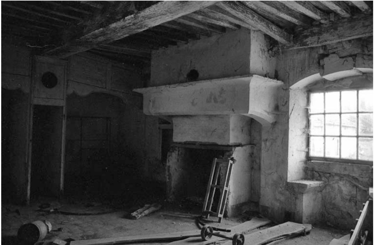
Intérieur : vue de la cheminée.
