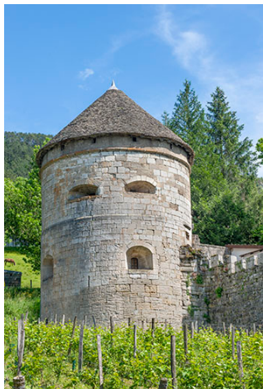
Vue rapprochée. Phot. Jérôme Mongreville IVR43_20243900689NUC4A
