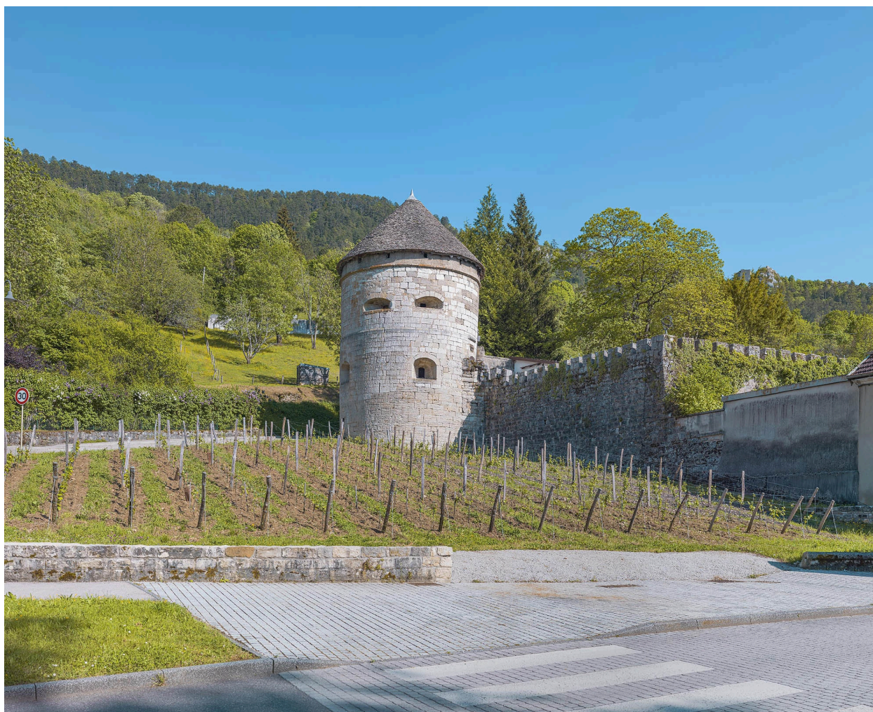
Vue depuis l'ouest.
