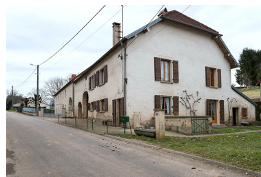
Ferme-bloc, 8 rue de la Garenne. Phot. Jérôme Mongreville IVR43_20167000891NUC4A
