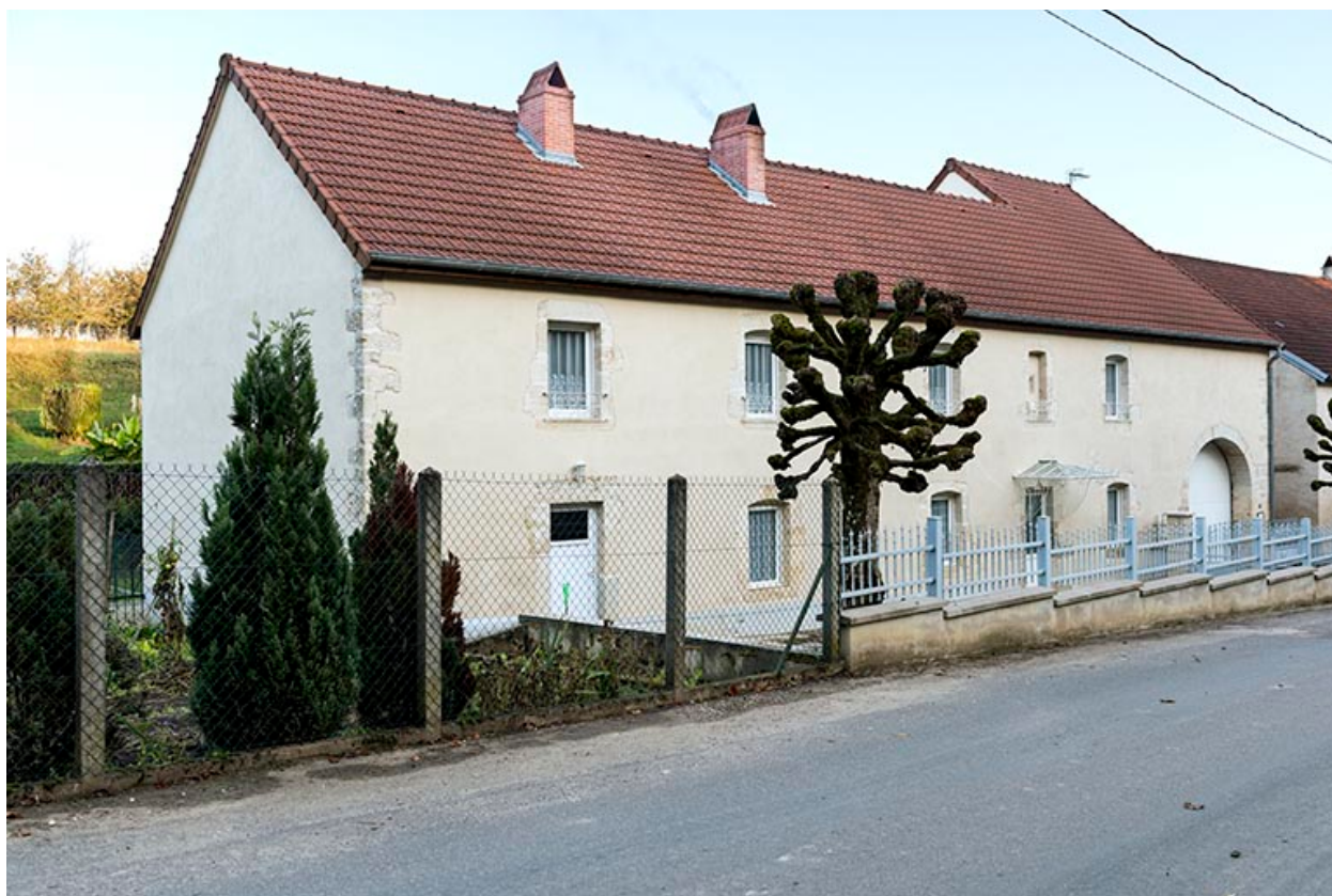
Ferme-bloc, 10-14 rue de la Garenne.
