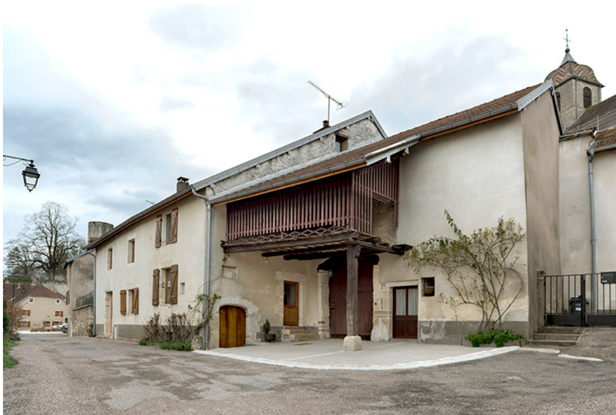
Ferme-bloc, 1 ruelle du Moulin. Les logis à gauche et la grange à droite sont couverts par deux toits différents ; notez la présence du "perché", avancée en bois en surplomb au-dessus de la porte de grange.
