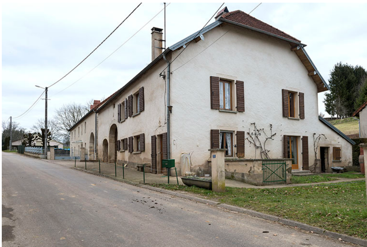
Ferme-bloc, 8 rue de la Garenne.
