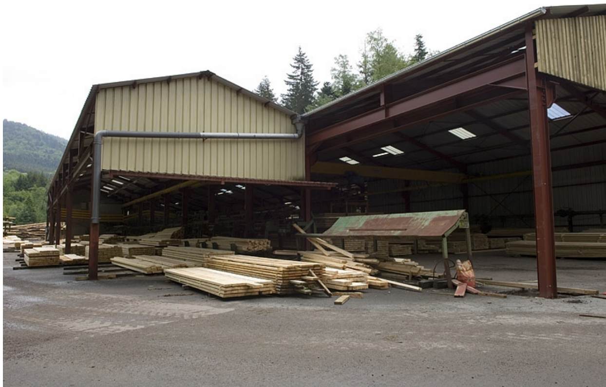
Atelier de fabrication de la nouvelle scierie.
