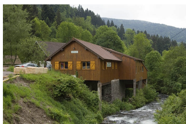
Bâtiment (réhabilité) de la scierie primitive. Phot. Jérôme Mongreville IVR43_20067000408NUCA
