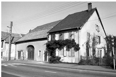
Vue de trois quarts. Phot. Bernard Lardière IVR43_19832500069Z
