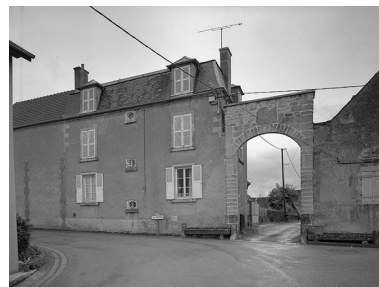
Portail d'accès à la basse-cour Phot. Jean-Luc Duthu IVR26_19945800020V
